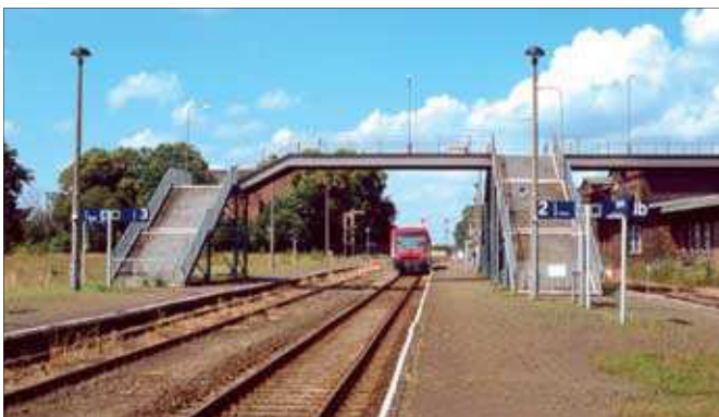
Fußgängerbrücken sind stets interessante Hochbauten im Bereich von Bahnsteigen an vielbefahrenen Strecken.
