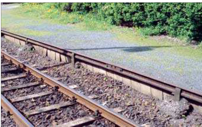
Resteverwertung: Altschienen dienen hier als Baumaterial für die Bahnsteigkante. Eine Schüttung aus Splitt bildet den Bahnsteigbelag.
