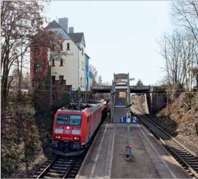
Blick vom Wartehäuschen herunter auf den Mittelbahnsteig mit dem modernen Treppenabgang (28.2.2010). Farbfotos: Ralf Kollig
