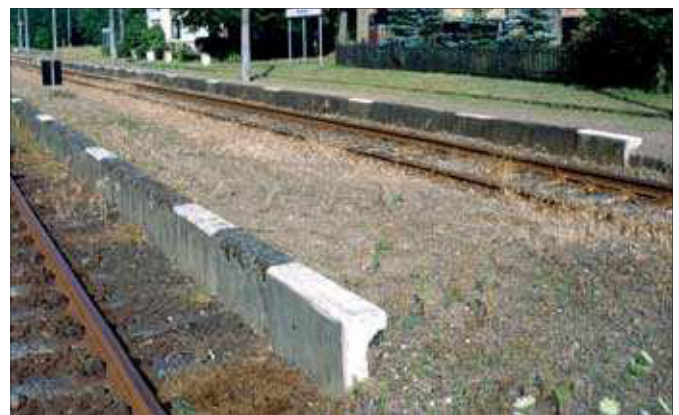
Diese Bahnsteigkante besteht aus einfachen Betonblcken, die mit Sand aufgefllt wurden – Nebenbahn pur.
