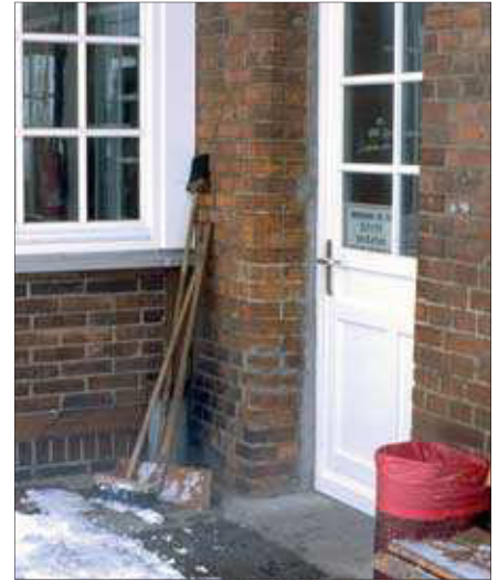
Im Winter dürfen Schneeschaukel, Besen und Weichenbesen an einem personalbesetzten Bahnhof keinesfalls fehlen.
