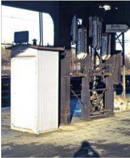
Einst befanden sich neben dem Zugzielanzeiger kleine Wellblechbuden mit einem Fernsprecher auf dem Bahnsteig.
