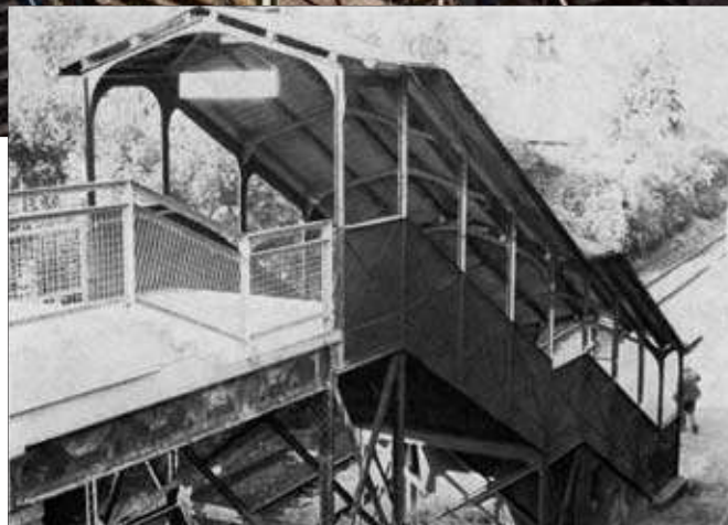
Auf dem linken Bild ist die frühere, relativ feine Stahlkonstruktion des Treppenabgangs zu sehen. Beachtenswert ist auch die Dachstruktur, die sich auf ähnliche Projekte übertragen lässt.
