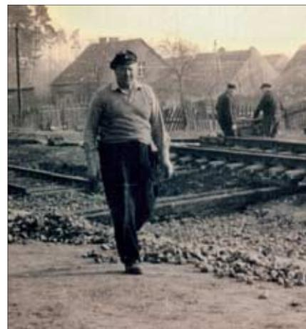
**Gleisbau im Bahnhof Dallmin, aufgenommen etwa 1964. Im Bild links ist deutlich der einfache Oberbau mit Kiesbettung zu sehen, mit dem der größte Teil des Streckengleises ausgestattet war. In der Regel besaßen nur die Weichen eine Schotterbettung.**
