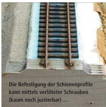
Die Befestigung der Schienenprofile kann mittels verlöteter Schrauben (kaum noch justierbar) ...
