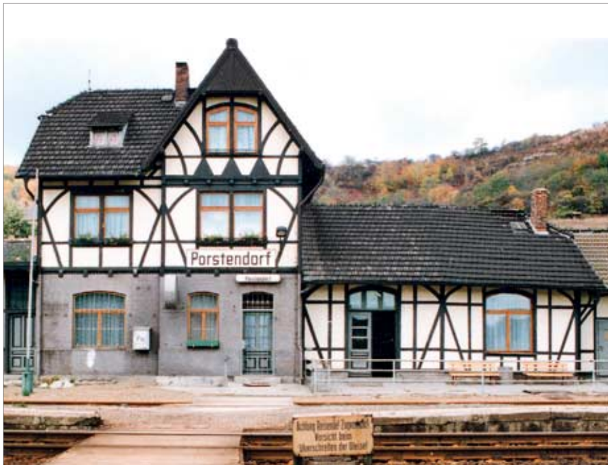
Das Empfangsgebäude des Anschlussbahnhofs Porstendorf (Zustand 1994) wurde im Erdgeschoss ursprünglich als Ziegelrohbau und im Ober- bzw. Dachgeschoss als verputzter Fachwerkbau und damit im landschaftsgebundenen Stil errichtet. Der südlich angesetzte Güterschuppen mit flachem Teerpappendach diente dem Stückgutverkehr. Foto: Rainer Ippen
