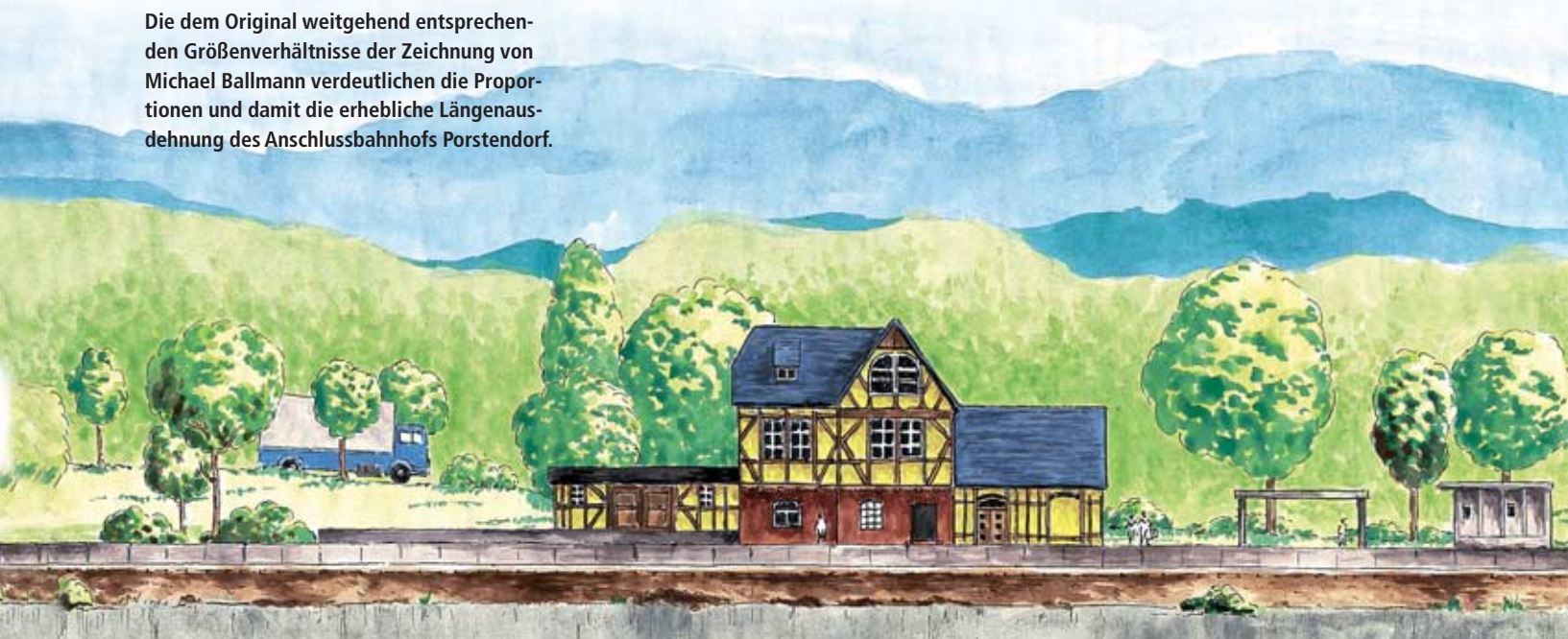
Das Empfangsgebäude des Anschlussbahnhofs Porstendorf (Zustand 1994) wurde im Erdgeschoss ursprünglich als Ziegelrohbau und im Ober- bzw. Dachgeschoss als verputzter Fachwerkbau und damit im landschaftsgebundenen Stil errichtet. Der südlich angesetzte Güterschuppen mit flachem Teerpappendach diente dem Stückgutverkehr. Foto: Rainer Ippen
