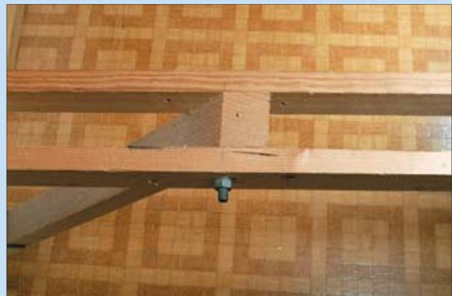
Detailansicht einer Diagonalstütze, jeweils mit einer 8-mm-Schlossschraube verbunden.
