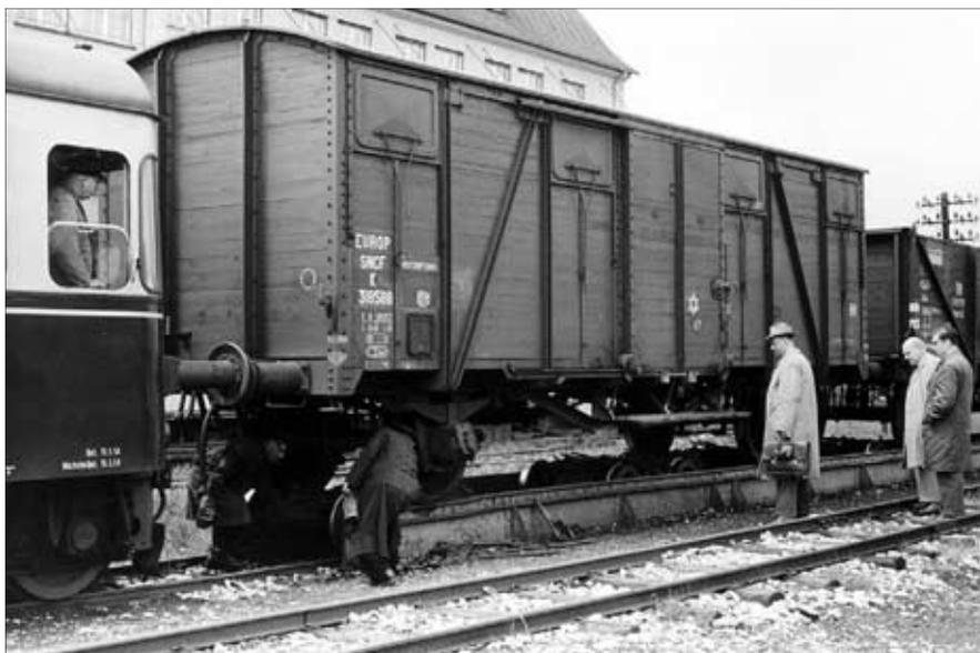
**Ganz genau wird das Aufbocken des gedeckten Güterwagens der SNCF inspiziert (Juli 1958). Als Triebfahrzeug dient der T 30 des Herstellers Fuchs, der mit einer Zug- und Stoßvorrichtung für regelspurige Fahrzeuge ausgerüstet ist. Foto: Bürnheim**
