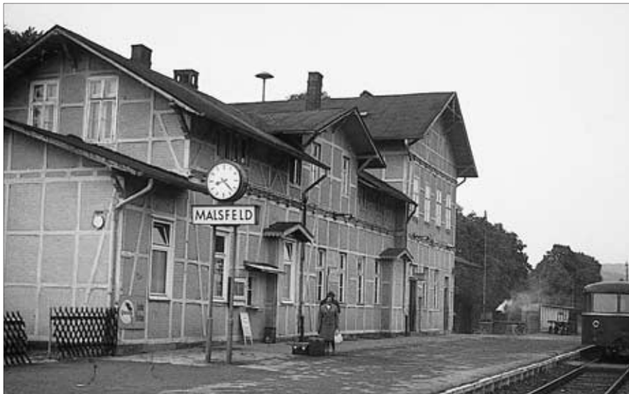
Das Empfangsgebäude ist mit seiner Ziegelstein/Fachwerk-Architektur typisch für die Kanonenbahn in dieser Region. Im Sommer 1966 steht Pto 1344 Waldkappel-Treysa am Hausbahnsteig (an Malsfeld 20.22 Uhr, ab 20.33 Uhr).
