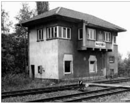
Das 1939 im Zuge der sicherungsmäßigen „Aufrüstung“ der Strecke Treysa–Malsfeld–Beiseförth–Bebra als Umleitungslinie gebaute Stellwerk Mf (Malsfeld Fahrdienstleiter) hat ein Pendant am westlichen Bahnhofskopf („Mw“ im Originalplan). Foto: Dr. V. Rödel
