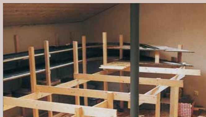
Erst nach Fertigstellung der Schattenbahnhöfe konnte es an den Unterbau des sichtbaren Teils gehen. Auch hier kamen wieder solide Kanthölzer zur Anwendung. Die geschwungene Anlagenvorderkante berücksichtigt die eisernen Dachstützen.
