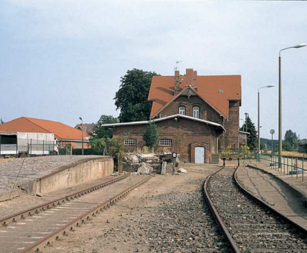
Endbahnhof Rehna der Nebenstrecke von Schwerin in Mecklenburg-Vorpommern: Die Anbindung des Güterschuppengleises (in Bildmitte) entspricht der Lösung im Gleisplan von Werlte. Auch die Bauweise des Empfangsgebäudes aus Ziegelmauerwerk war über ganz Norddeutschland verbreitet.
