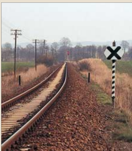
Kreuztafel als Vorsignal an der einstigen Nebenbahn von Güstrow nach Pritzwalk. Im Hintergrund ein modernes Einfahrsignal.
