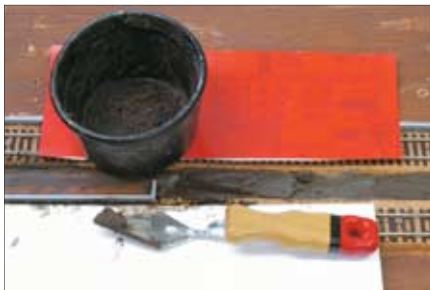
Vor dem Auftragen des Sandspachtels werden die Gleise abgedeckt.
