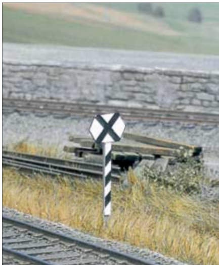
Eine Kreuztafel steht im Bremswegabstand vor einer Trapeztafel, einer Deckungsscheibe und auch vor Form- und Lichtsignalen im Bereich der ehemaligen DR.
