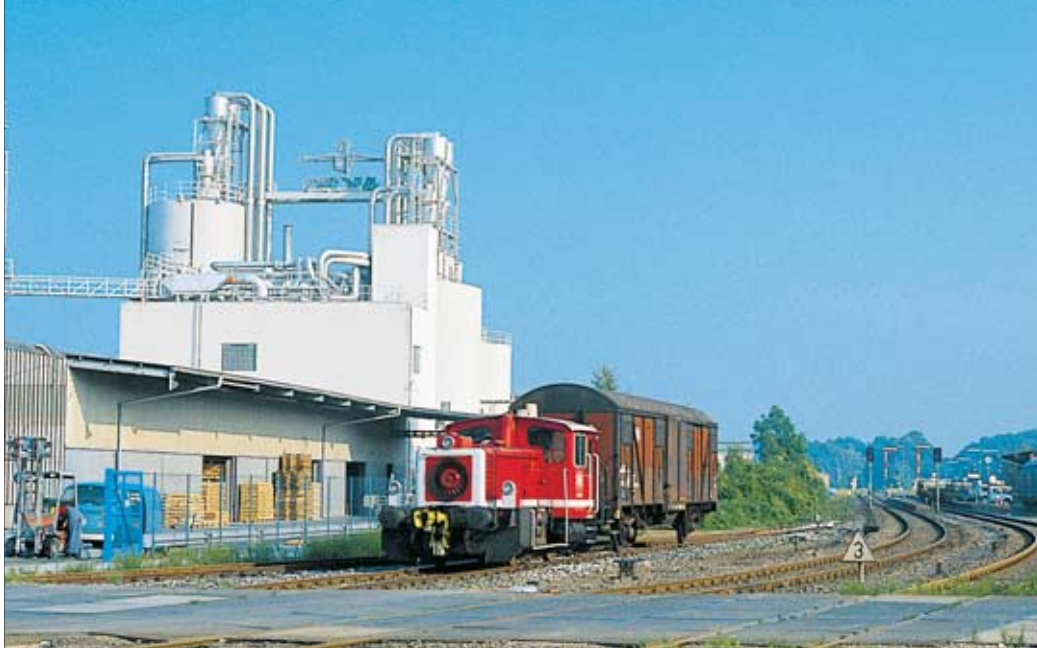
Ansicht des Bahnhofs Lendersdorf von der südlichen Einfahrt her. An der Chemiefabrik wird gerade ein Güterwagen zugestellt (Juli 1991).
