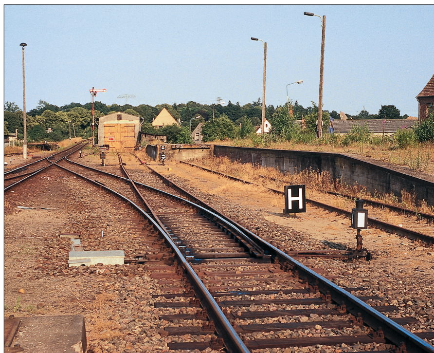
Auch das war bei vereinfachtem Nebenbahndienst möglich: Der Kreuzungsbahnhof Crivitz der Strecke Schwerin–Parchim erhielt an seinem östlichen Bahnhofskopf ein Gruppenausfahrsignal, das für zwei durchgehende Hauptgleise galt. Die Züge hielten zwar kurz vor der H-Tafel, aber nicht auf der Weiche. Die Weiterfahrt bedurfte neben der Signalstellung Hf 1 (Fahrt frei) eines Fahrbefehls durch den Dienst habenden Betriebseisenbahner. Fotos: Franz Rittig
