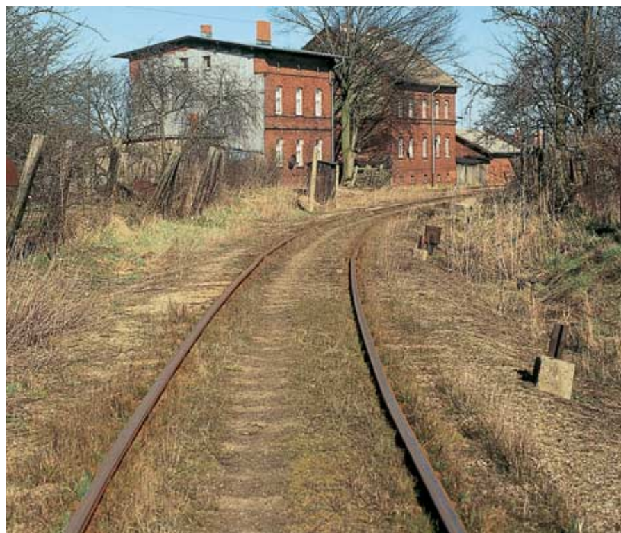
Einfahrt der Nebenbahn aus Tribsees in den Bahnhof Velgast. Hier liegen die Gleise in einer Sandbettung – immerhin schon mit Betonschwellen. Foto: fr
