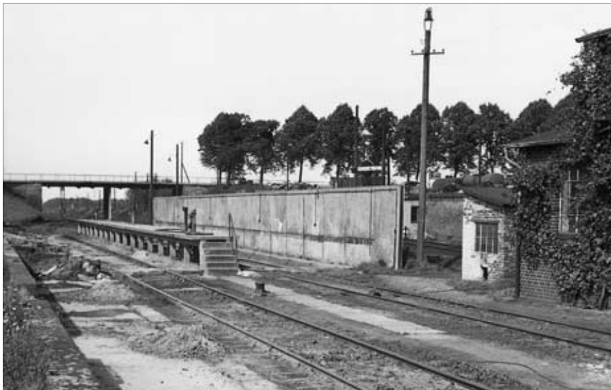
Die Reinigungs- und Entseuchungsanlage für Viehwagen im Bahnhof Paderborn. Die Reinigung der Wagen erfolgt von einer erhöhten Arbeitsbühne aus; da dabei jede Menge Schmutz anfällt, wird die Anlage zu den Durchgangsgleisen hin von einer Wand aus Betonplatten abgeschildert. Unter dem Plattenweg zwischen den Gleisen liegen auch die Leitungen vom Kesselhaus zur Bühne; Abwasser und Viehmist werden in einer mit Ziegeln ausgemauerten Jauchegrube gesammelt, die mit Brettern abgedeckt werden kann. Die zur Reinigung bestimmten Viehwagen lassen sich mithilfe von Umlenkrollen und einer Seilwinde bewegen, die in einer separaten Bude untergebracht ist. Fotos: Rolf Ertmer
