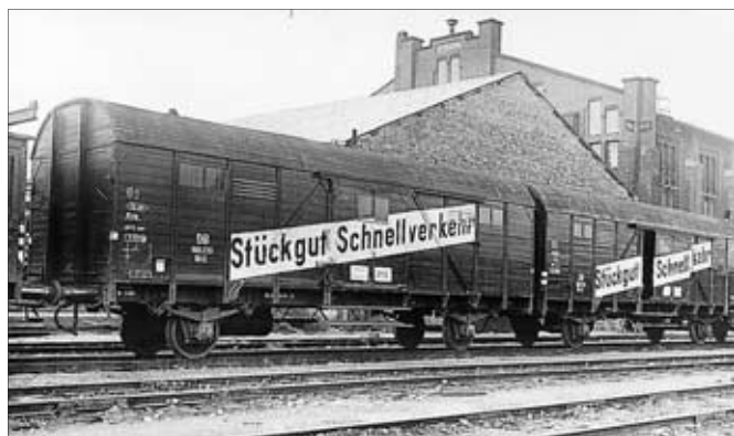
Ab 1932 kamen zwei kurz gekuppelte GI als Leig-Einheit zum Einsatz. Einer der beiden Wagen wurde dazu mit dem für Packwagen üblichen Zugführerabteil und einer Toilette nachgerüstet. Neu war ferner die diagonal gehaltene Anschrift. Fotos: Archiv MIBA
