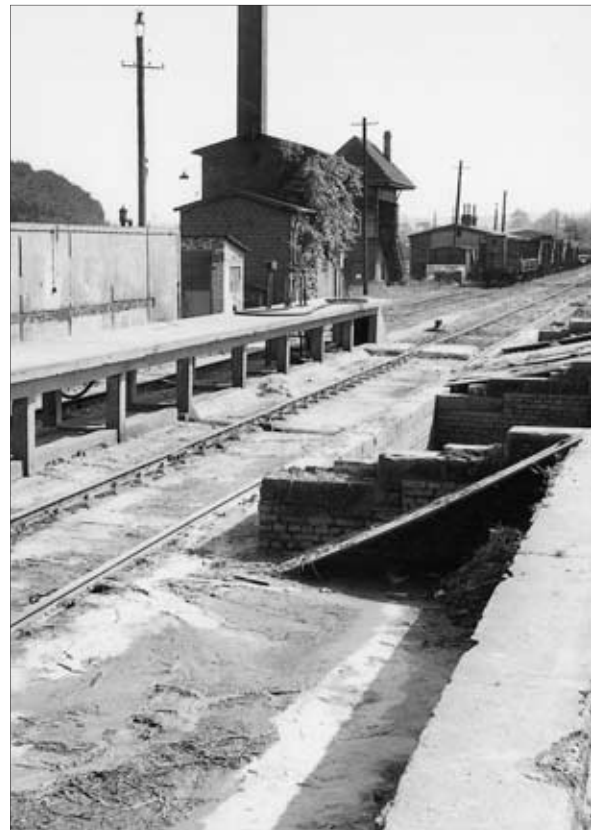
Die Reinigungs- und Entseuchungsanlage für Viehwagen im Bahnhof Paderborn. Die Reinigung der Wagen erfolgt von einer erhöhten Arbeitsbühne aus; da dabei jede Menge Schmutz anfällt, wird die Anlage zu den Durchgangsgleisen hin von einer Wand aus Betonplatten abgeschildert. Unter dem Plattenweg zwischen den Gleisen liegen auch die Leitungen vom Kesselhaus zur Bühne; Abwasser und Viehmist werden in einer mit Ziegeln ausgemauerten Jauchegrube gesammelt, die mit Brettern abgedeckt werden kann. Die zur Reinigung bestimmten Viehwagen lassen sich mithilfe von Umlenkrollen und einer Seilwinde bewegen, die in einer separaten Bude untergebracht ist. Fotos: Rolf Ertmer
