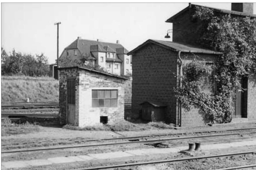
Die Reinigungs- und Entseuchungsanlage für Viehwagen im Bahnhof Paderborn. Die Reinigung der Wagen erfolgt von einer erhöhten Arbeitsbühne aus; da dabei jede Menge Schmutz anfällt, wird die Anlage zu den Durchgangsgleisen hin von einer Wand aus Betonplatten abgeschildert. Unter dem Plattenweg zwischen den Gleisen liegen auch die Leitungen vom Kesselhaus zur Bühne; Abwasser und Viehmist werden in einer mit Ziegeln ausgemauerten Jauchegrube gesammelt, die mit Brettern abgedeckt werden kann. Die zur Reinigung bestimmten Viehwagen lassen sich mithilfe von Umlenkrollen und einer Seilwinde bewegen, die in einer separaten Bude untergebracht ist. Fotos: Rolf Ertmer
