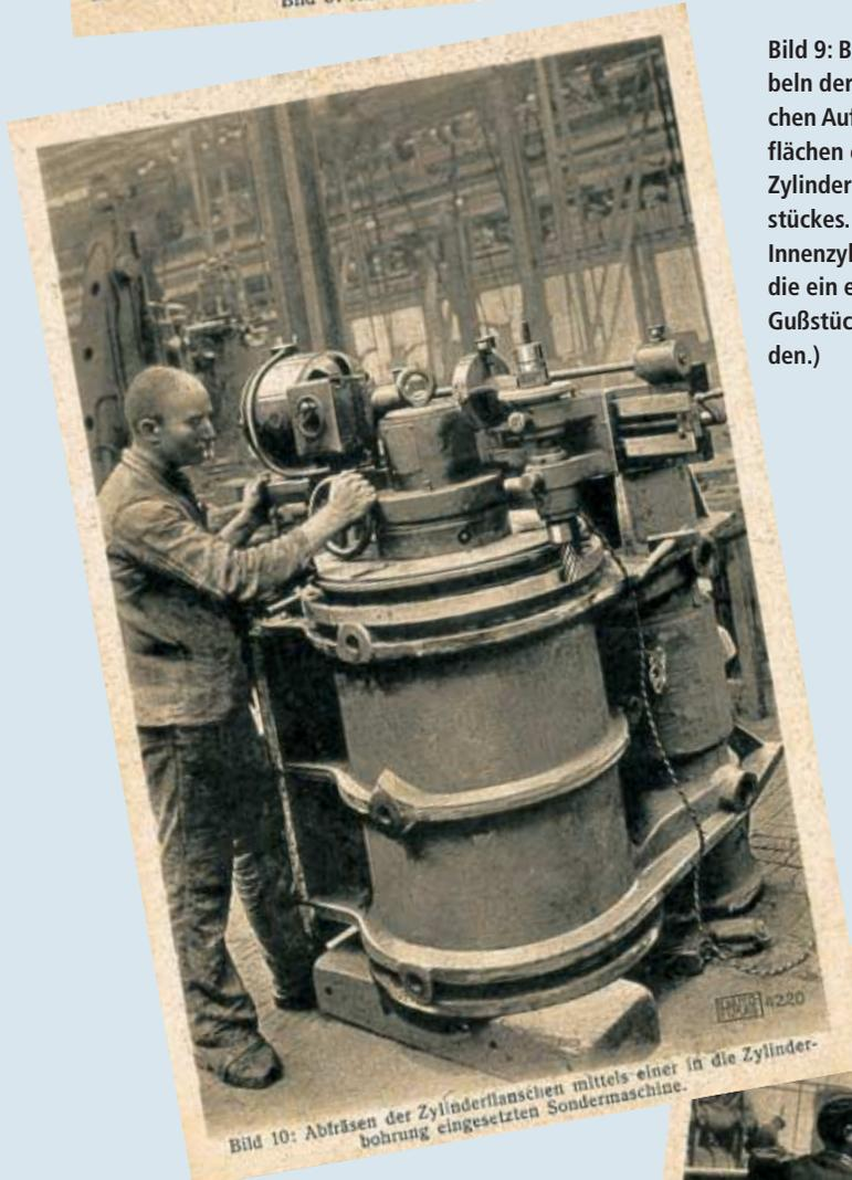
Bild 10: Abfräsen der Zylinderflanschen mittels einer in die Zylinderbohrung eingesetzten Sondermaschine.
