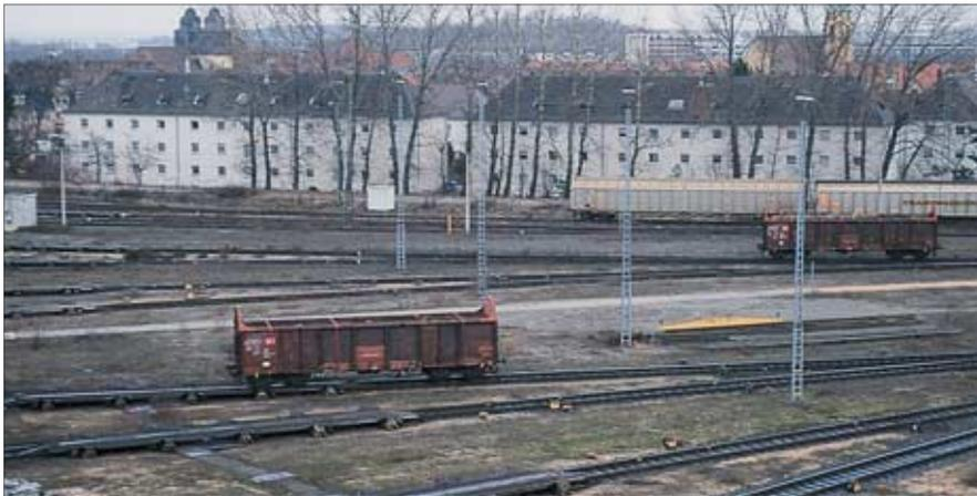
Unten: Wagen 3180 5931 293-0 hat alle Bremsen passiert und rollt nun auf der Retarder-Beharrsstrecke des Richtungsgleises 041 mit konstanter Geschwindigkeit.
