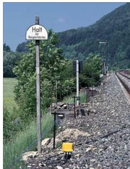
Rangierhalttafeln werden am Ende des Durchrutschwegs von Einfahrsignalen aufgestellt. Auf den Bildern aus Hartmannshof – Juni 1985 – und Kuhfelde (DR) – Oktober 1991 – (ganz links, Foto: Slg. SC) sind diese Signale im Hintergrund zu erkennen.
