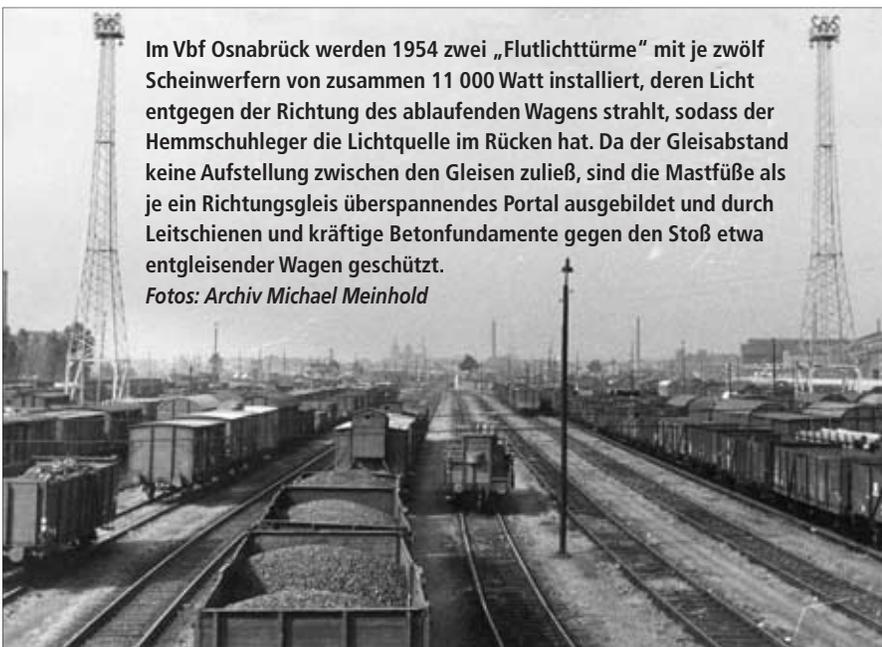
Im Vbf Osnabrück werden 1954 zwei „Flutlichttürme“ mit je zwölf Scheinwerfern von zusammen 11 000 Watt installiert, deren Licht entgegen der Richtung des ablaufenden Wagens strahlt, sodass der Hemmschuhleger die Lichtquelle im Rücken hat. Da der Gleisabstand keine Anstellung zwischen den Gleisen zuließ, sind die Mastfüße als je ein Richtungsgleis überspannendes Portal ausgebildet und durch Leitschienen und kräftige Betonfundamente gegen den Stoß etwa entgleisender Wagen geschützt.
