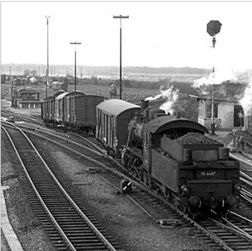
Zwar ist auf dem Foto aus dem Rbf Gremberg vom Februar 1957 leider das Signalbild des Abdrücksignals nicht zu erkennen, aber da das Bild die Atmosphäre des Abdrückbetriebs mit der 55 4407 sehr gut einfängt, soll es hier trotzdem abgedruckt werden. Foto: Bustorff
