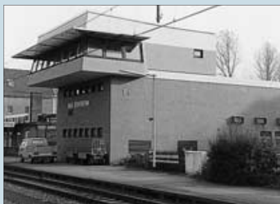
Oben das 1978 erbaute Dr-Stellwerk, das auf dem Bild rechts – Güterschuppen mit Ladestraße, Lademaß und Kran – im Hintergrund zu erkennen ist. Fotos: Rolf Köstner
