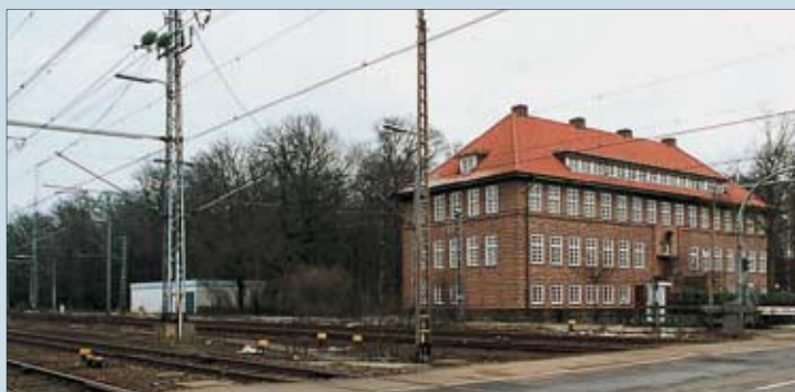
Das BE-Verwaltungsgebäude, in den frühen Dreißigerjahren von Fritz Höger (Chilehaus Hamburg) erbaut; hinten das Schalthaus Ost. Fotos: Ivo Cordes
