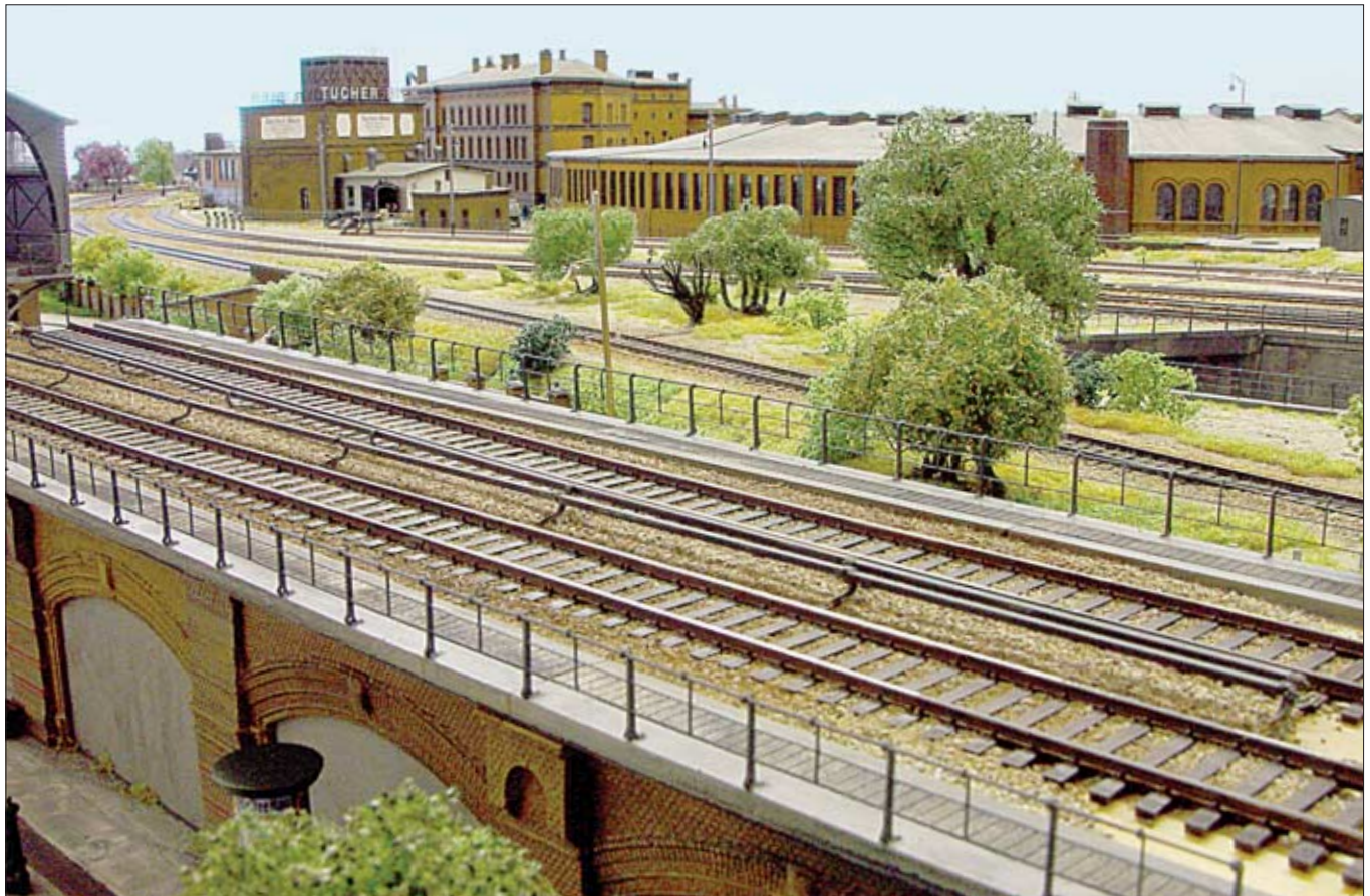
Blick vorbei am Haltepunkt Stralauer Tor auf den Schuppen I und das Verbindungsgebäude.
