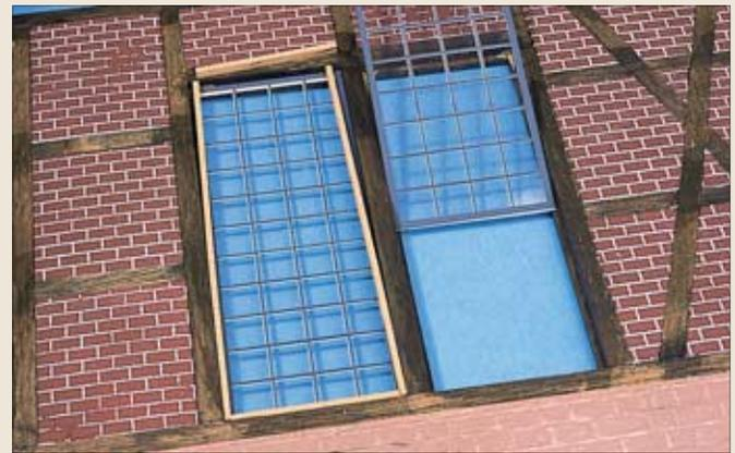
Links oben: Die Fensterhälften wurden mit der eingelegten Folie auf der Kante mit Sekundenkleber fixiert. Danach erfolgte das vorbildgerechte Einsetzen mit Holzleisten, die noch mit Beize getönt werden.
