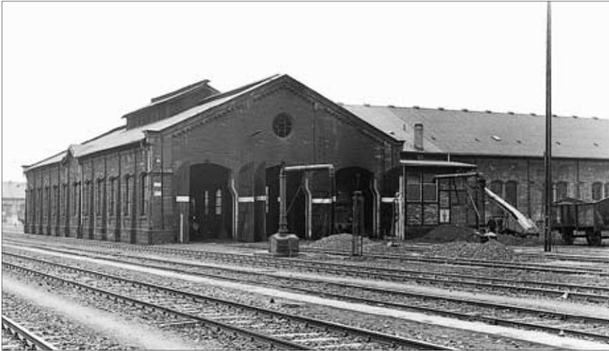
Selbst Betriebswerke an Hauptbahnen mussten durchaus keine Rundschuppen mit Drehscheiben aufweisen. In Lauda an der Strecke Würzburg–Stuttgart gab es etwa einen großen rechteckigen Bau, dessen Gleise über Weichenverbindungen statt über eine teure und unterhaltsaufwändige Drehscheibe angeschlossen waren. Das Prinzip verdeutlicht die Gleisskizze der Lokremise des Bf Löbau um 1875 (unten).
