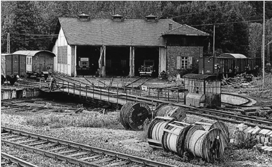
Der Ringlokschuppen mit Drehscheibe bietet den Vorteil, stets Zugriff auf jede Lokomotive zu haben, was bei größeren Rechteckschuppen mit hintereinander angeordneten Ständen oft mit einigem Umstand verbunden war. Daher verbreitete sich die Kombination von Drehscheibe und Ringschuppen rasch und nachhaltig, selbst bei relativ kleinen Anlagen mit weniger als zehn Ständen wie im Bw Rottweil (unten) oder sogar im Bw Eberbach mit nur drei Ständen (links).
