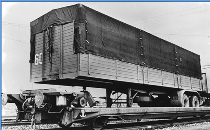
Jeder Einzelwagen der Einheit SSis 60 (Bauart Aachen) nimmt einen Sattelanhängen auf, dessen Zapfen während des Schienentransports in einer Pendelstütze gelagert ist. Nach den Versuchsmustern von 1961 wurden ab 1962 insgesamt 140 Einheiten als Laas 608 gebaut. *Foto: Archiv Michael Meinhold*
