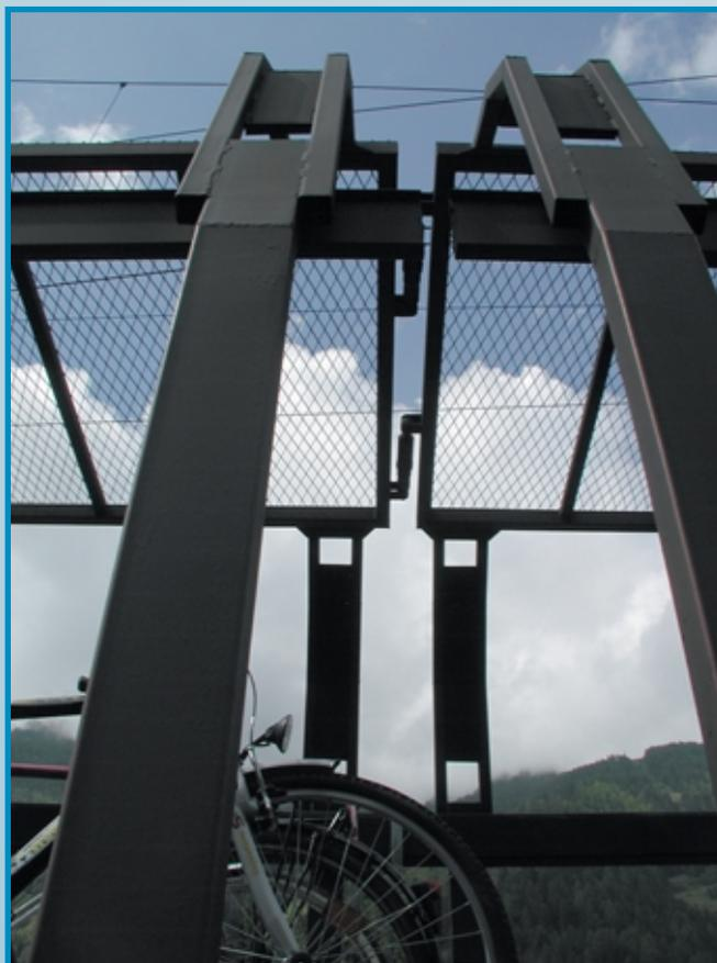
Der Blick nach oben zeigt neben Details der Käfigkonstruktion und der Gitterdrahtabdeckung auch die „Stoßdämpfer“ zwischen den Käfighälften.
