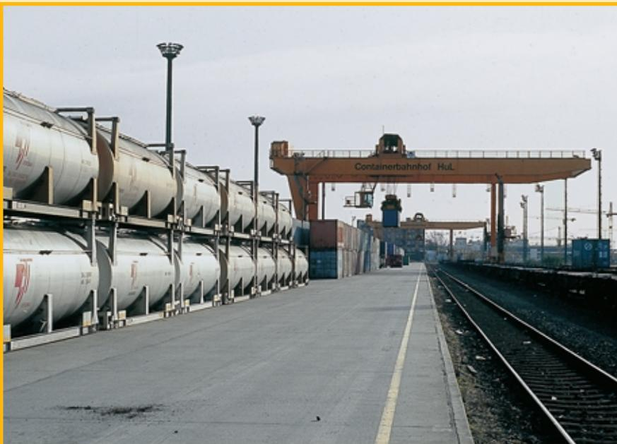
Die großen Portalkräne können vier Gleise überspannen. Links stehen Tankbehälter, die in den Eckbeschlügen Containern entsprechen und wie diese umgeladen werden.
