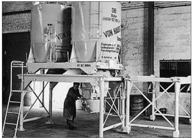
Das Befüllen der Zementbehälter erfolgte über eine Öffnung im Deckel. Das Entleeren an einer Baustelle geschah jedoch durch eine Öffnung im Boden. Dazu musste der Behälter auf einem Gestell abgesetzt werden. In dem Gestell ist noch eine Dosier- und Wiegeeinrichtung integriert. Fotos: Archiv Michael Meinhold, MIBA-Archiv
