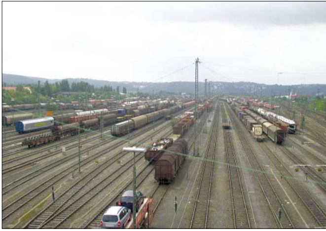
Güterwagen, soweit das Auge reicht. In Hagen-Vorhalle betreibt DB-Cargo einen auch in Zukunft stark frequentierten Stützpunkt. Dort wo die Loks abgestellt sind (rechts), befand sich früher das Bw.
