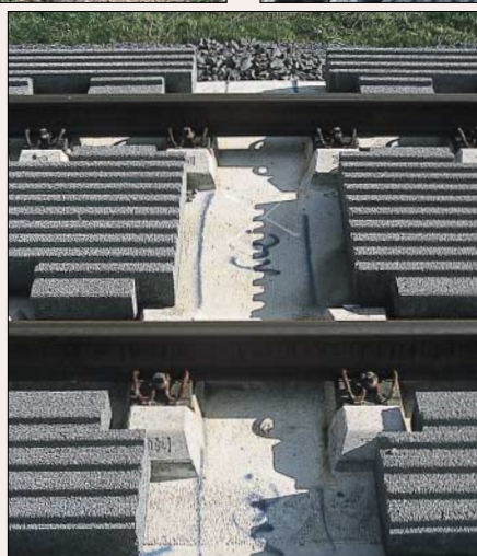
Feste Fahrbahn mit durchgehender Beton-schwelle.
