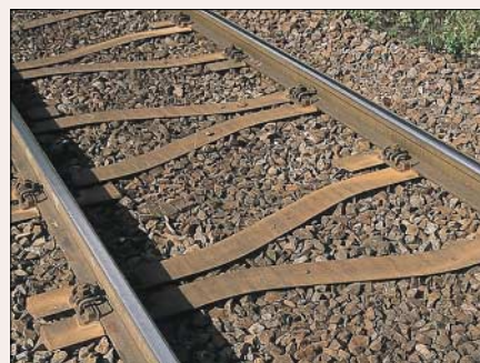
Die Schwellen liegen abwechselnd gespiegelt.
