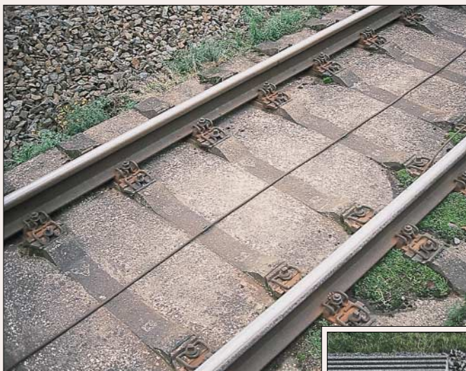
Feste Fahrbahn mit durchgehender Beton-schwelle.
