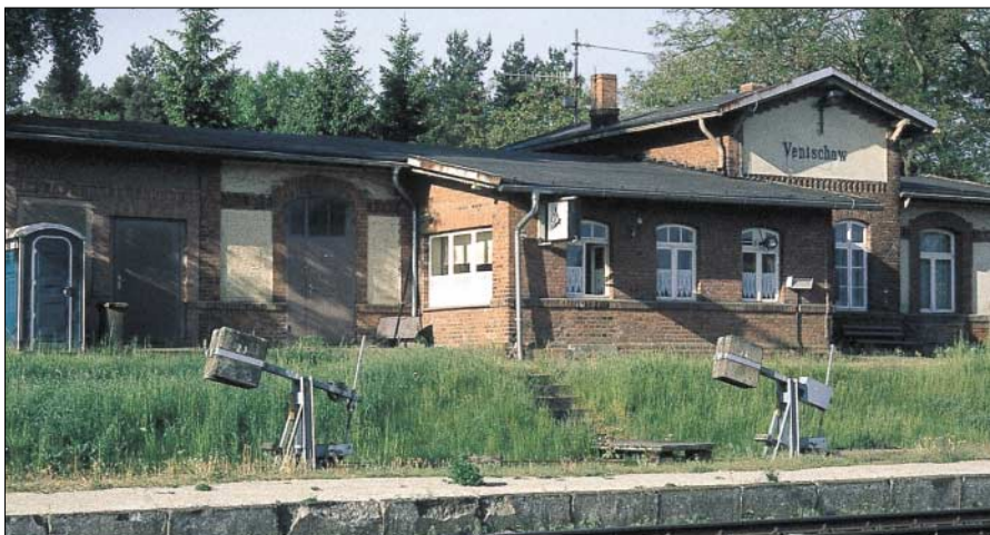
Auch das eine Anregung für den Modellbahner: Die Stelldrähte werden von der Hebelbank unter der Geländestufe hindurch auf das Niveau des Bahnsteigs geführt und durch Spannwerke straff gehalten.
