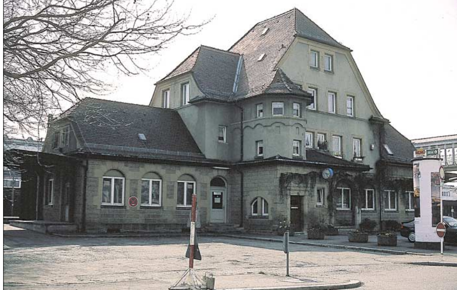
Das Bahnhofgebäude von Sindelfingen von der Straßenseite aus gesehen. Es musste im Lauf der Zeit schon einige Umbauten über sich ergehen lassen.
