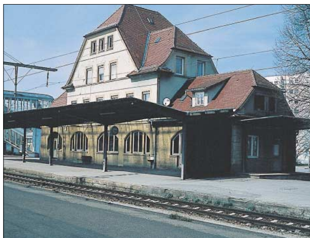
Rechts: Die Bahnsteigüberdachung im Detail. Zum Gebäude hin ist sie verglast, damit die Fenster des Erdgeschosses mehr Licht erhalten.
