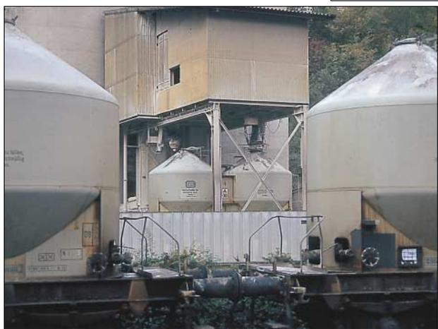
In Stromberg/Hunsrück wird Kalkmehl für die BASF in Staubbehälterwagen verladen. Die eigentliche Verladestelle besteht aus einem Schnorchel, mit dessen Hilfe über Druckluft das staubige Ladegut eingefüllt wird.
