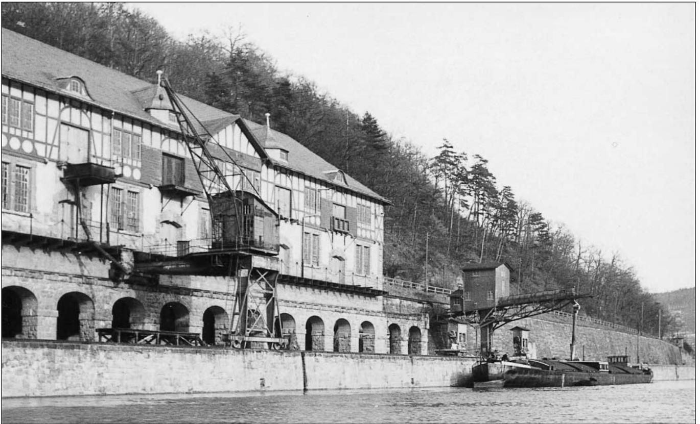
Die Weserumschlagstelle in den Sechzigerjahren. Rechts neben dem Gebäude ist die später gebaute Kaliverladeanlage zu sehen. Dort konnten zwei Wagen gleichzeitig entladen werden. Arbeiter entluden die Wagen mit großen Schaufeln auf ein Förderband. Über die Bänder gelangte das Kali in den Verladeturm, über eine Förderschnecke auf ein weiteres Förderband und von da durch die Ladeluken in die Laderäume der Schiffe.
