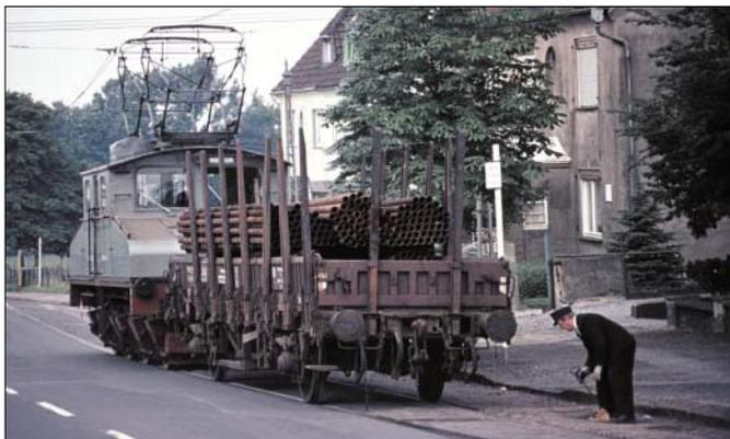
Am 11.2.1966 passiert ein Zug den Anschluss der Fa Joest. Bemerkenswert ist der Mast mit beidseitigem Ausleger, der sowohl den Fahrdrabt des Streckengleises wie auch des Anschlusses trägt.
