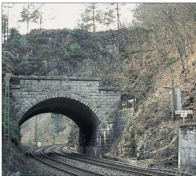
Solche Kurztunnel kommen auf der Schwarzwaldbahn öfter vor: Oben der so genannte 3. Glasträger-Tunnel, rechts die (leicht stilisierte) Modellnachbildung eines derartigen Kurztunnels.
