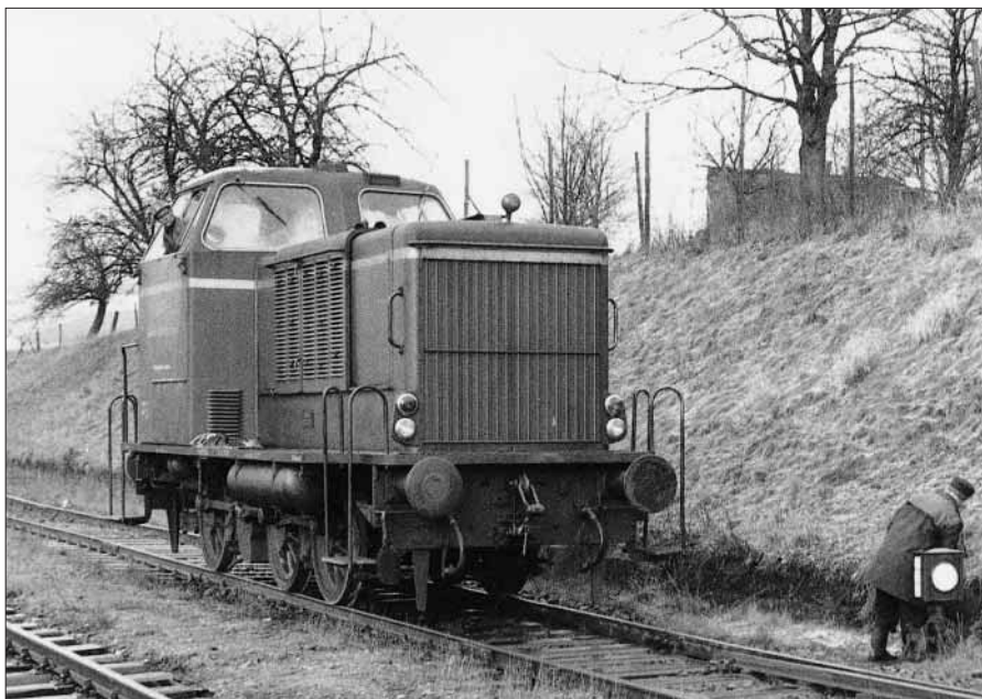
Die C-gekuppelte Stangendiesellok 272 nochmals solo im Bahnhof Gittelde; sie wurde 1955 mit Marshallplan-Geldern vom Niedersächsischen Landeseisenbahnamt (NLEA) beschafft und löste ...
