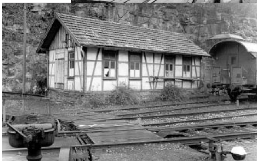
1972 noch vorhanden, inzwischen längst ausgebaut: die 16-m-Drehscheibe, deren Details inkl. Kurbelantrieb hier gut zu erkennen sind.
