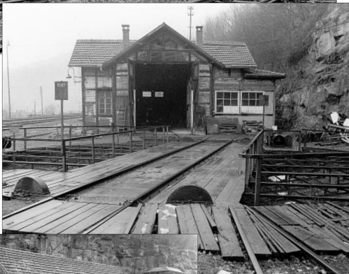
1972 noch vorhanden, inzwischen längst ausgebaut: die 16-m-Drehscheibe, deren Details inkl. Kurbelantrieb hier gut zu erkennen sind.
