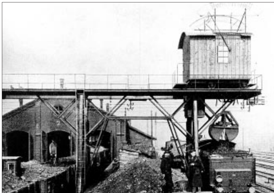
In Mannheim Pbf entstand 1902 in Deutschland der erste Bekohlungskran mit Laufkatze. Mittels einer im Führerhaus befindlichen Waage konnte die Kohlenmenge festgehalten werden.
