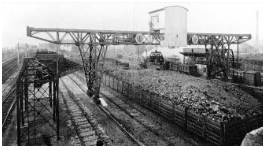
Die 1903/04 im Bw Frankfurt/M entstandene Bekohlungsanlage mit einer Laufkatze auf der großen Verladebrücke und die in Reihe aufgestellten Taschenbunker für die Bekohlung der Loks blieb lange Zeit Vorbild für weitere Anlagen in Deutschland.
