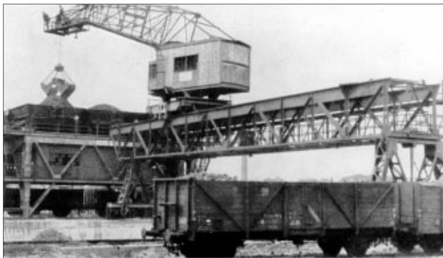
Der letzte gebaute Brückenlaufkran entstand nach dem 2. Weltkrieg im Bw Braunschweig. Der Drehkran bediente den fahrbaren Großbunker der Einheitsbauart der DB, leerte den Schlackenkanal und frischte die Sandvorräte auf. Fotos (5): Sammlung Markus Tiedtke
