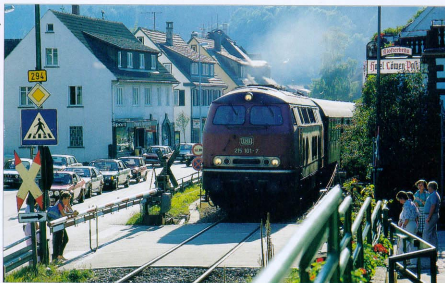
Hier wird's eng – wie auf der Modellbahn: Bahnübergang an der Ortsdurchfahrt des Schwarzwaldstädtchens Alpirsbach. Am Warnkreuz links wurden die Schenkelenden nachträglich „begradigt“, offensichtlich um die Verletzungsgefahr für Fußgänger und Radfahrer zu verringern.
