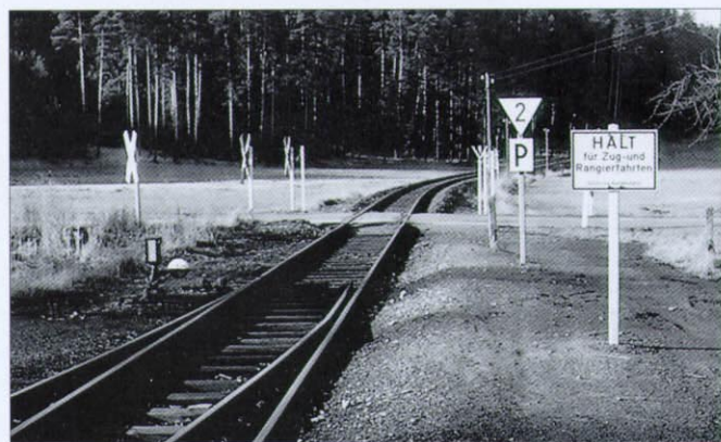
Technisch unsicherer Bahnübergang bei Neuenreuth/Main (Frühjahr 1975). Hier muß der Zug grundsätzlich halten. Ein Relikt aus betriebsintensiveren Zeiten ist die Pfeiftafel mit Geschwindigkeitstafel.
