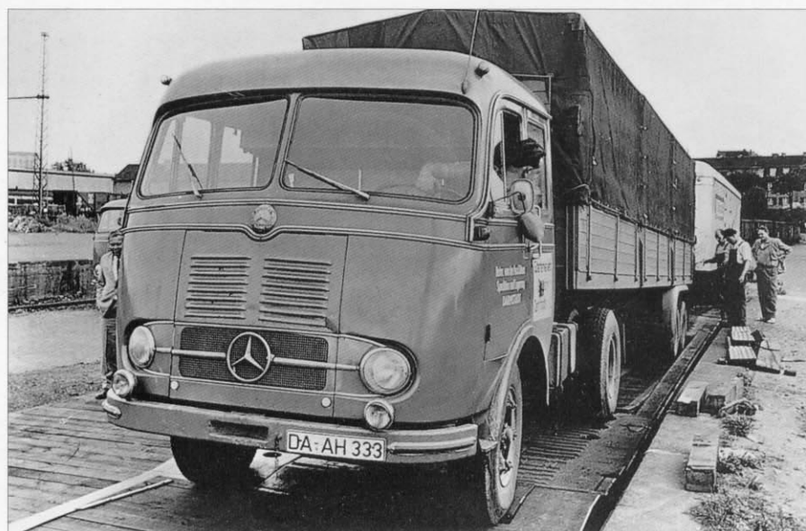
... beim Einfahren des Straßenfahrzeugs bis auf eine tiefste Ladehöhe von 400 mm über SO absenkt. 72 dieser Huckepackeinheiten sind im Jahr 1965 vorhanden und im Verkehr mit unternehmereigenen Aufliegern eingesetzt, weitere 50 sind bestellt.
