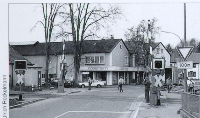
Bahnübergang am Bahnhof Oberviechtach im April 1988. Ein echtes Kuriosum ist die Blinklichtanlage: rechts in Form der fünfziger, links in Form der sechziger Jahre.
