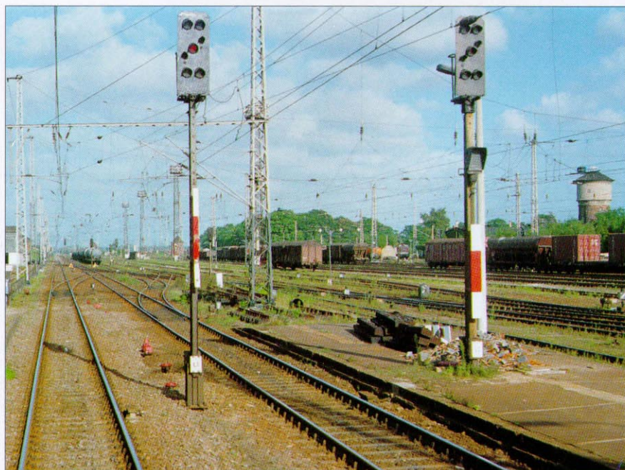
Zwei HI-Signale mit hohen Signalmasten, aufgenommen im Bahnhof Ludwigslust. Der rechte Mast besteht aus Schleuderbeton. Foto: Gerd Naumann
