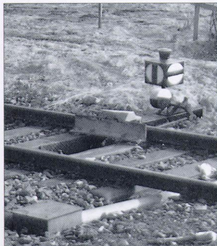
Bei der DB gilt das Signal Sh 1 nur als Fahrauftrag, wenn sich am Signalmast die auf der Spitze stehende, quadratische weiße Scheibe befindet (links).
