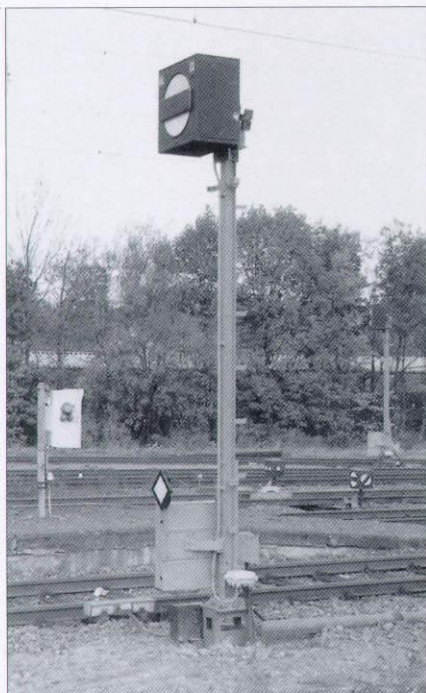
Bei der DB gilt das Signal Sh 1 nur als Fahrauftrag, wenn sich am Signalmast die auf der Spitze stehende, quadratische weiße Scheibe befindet (links).
