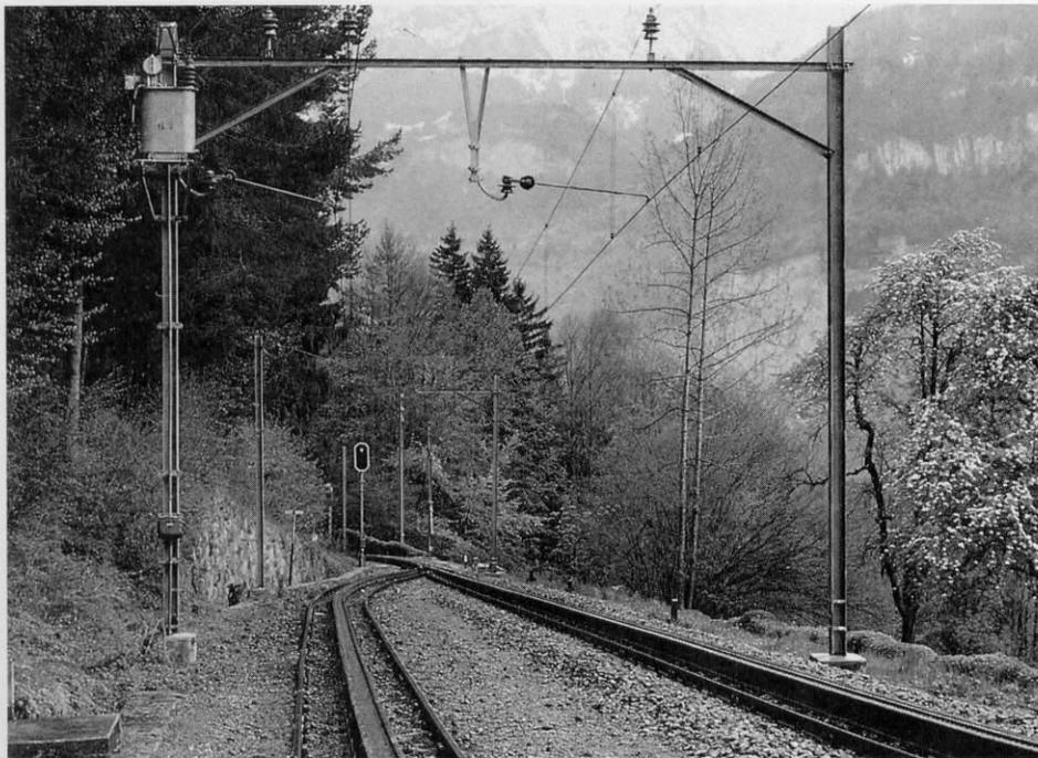
*Blick vom Betriebsgebäude in Richtung Meiringen mit geschlossenem Ausfahrtsignal. Der am Fahrleitungsmast oben angeflanschte Ausleger trägt einen Kleintransformator. Er versorgt die elektrische Weichenheizung im Winter mit Spannung.*
