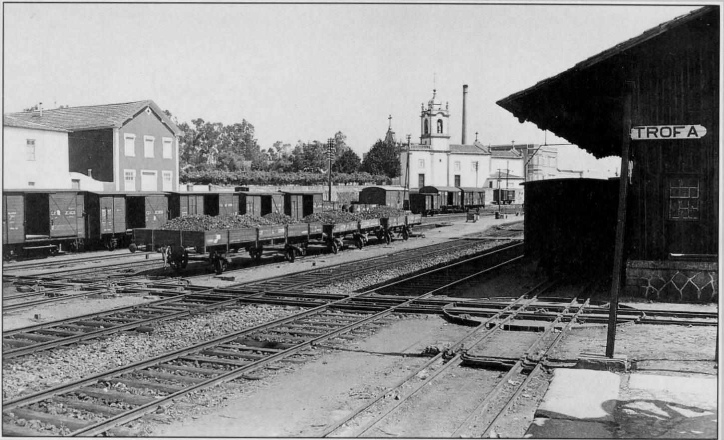
In Bf Trofa stößt die Schmalspur von Porto Trindade auf die Minho-Linie. Vier Schienen-Gleis. In Lousado zweigt sie ab nach Guimarães (oben).
