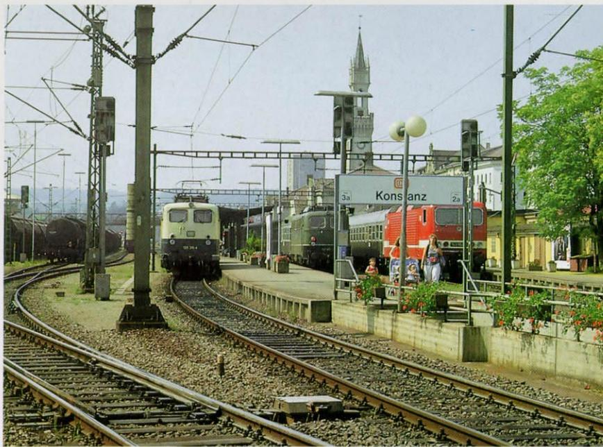
◀ Der Bahnhof in südlicher Richtung. Die Gleise 1–3 dienen den Personenverkehr. Besonders interessant: Sie werden von Oberleitungsquertragwerken Schweizer Bauart überspannt.
