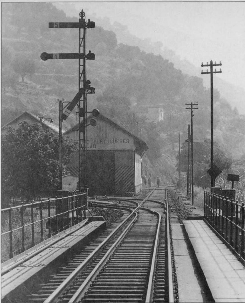
Das portugiesische Netz wurde mit dem Einsatz von ausländischem Kapital und Material gebaut. Gleich hinter der Corgo-Brücke bei Régua befindet sich dieses Flügel-signal, das nach englischem Muster die Fahrwege anzeigt. Freie Fahrt hat hier ein Breitspurzug von der Brücke her. Der mittlere Flügel gilt für den Breitspurabzweig in die Betriebswerkstatt, der obere für die Meterspurbahn, die hier vom Vierschienengleis ins Corgo-Tal und in Richtung Chaves abbiegt.
