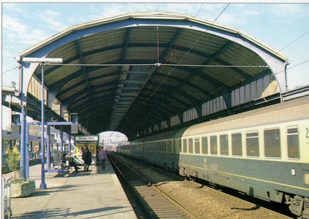
Halle von Bonn Hbf über zwei Gleise (oben). Ansicht aus Richtung Koblenz. Blechträger-Bogen auf einzelnen Eisenstützen. Das Zugband hält den Dachstuhl in Form.
