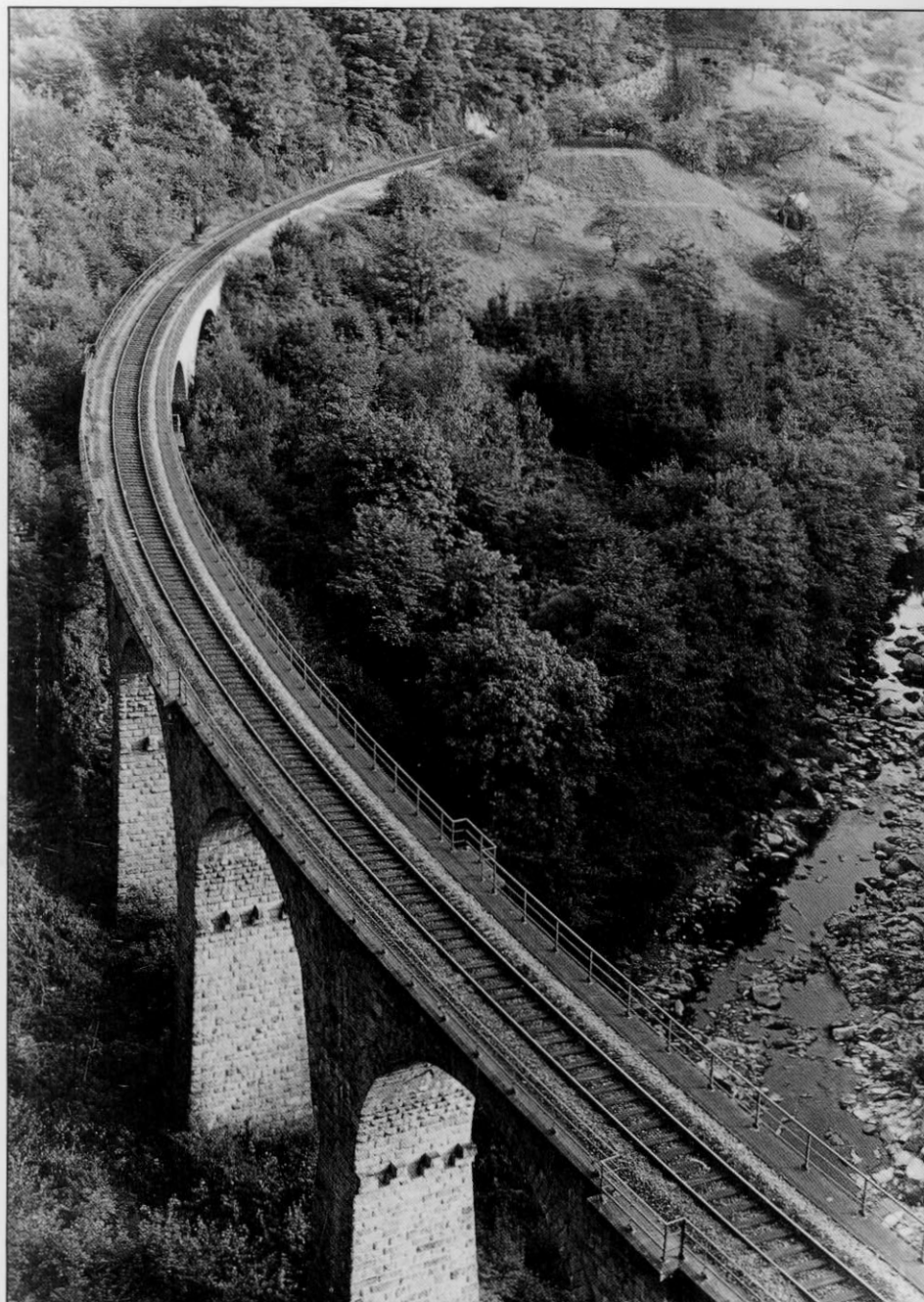
Selten kann man eine Vorbildbrücke aus solch „gehobener“ Perspektive betrachten wie hier den Viadukt bei Weisenbach auf der Murgtalbahn. Auf Stein- oder Beton-Gewölbeviadukten ist das Gleis stets eingeschottert, seitliche Fußwege mit Austritten über den Pfeilern. Foto: Herbert Stemmler
