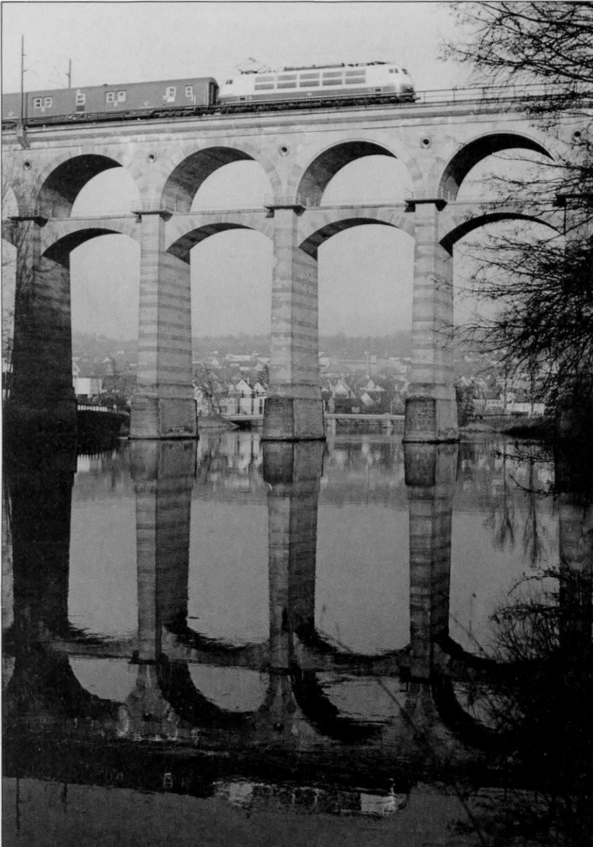
In früherer Zeit wurden Bogenviadukte oft zweistöckig ausgeführt; die untere Gewölbereihe dient nur zur Aussteifung der schlanken Pfeiler. Hier spiegelt sich die Bietigheimer Brücke im Wasser der Enz. Foto: Herbert Stemmler
