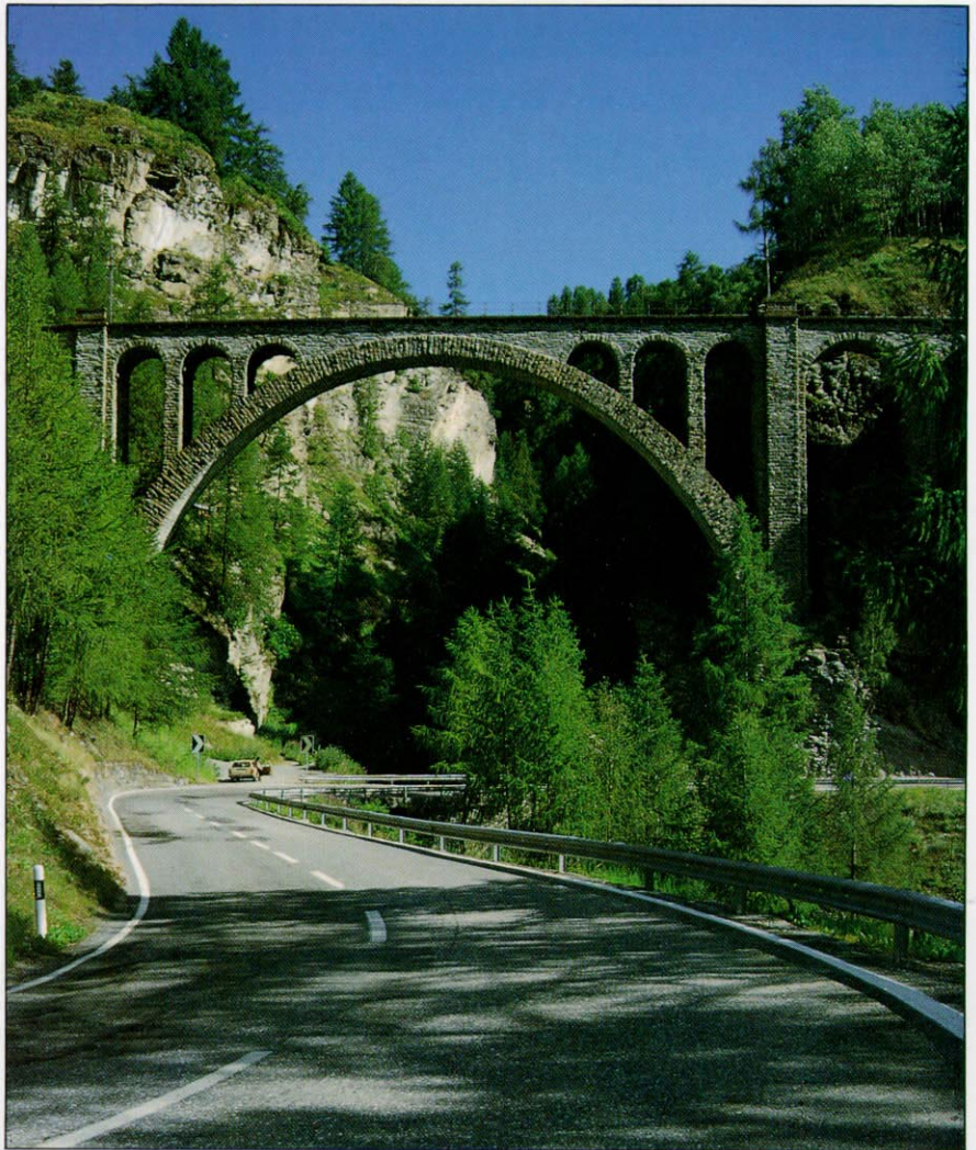
Ein Beispiel für eine Bogenbrücke mit durchbrochenem Aufbau: der Val-Tuoi-Viadukt im Unterengadin. Foto: Gebhard J. Weiß
