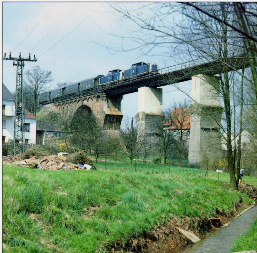
Die Bilder dieser Doppelseite: Sauber bearbeiteter Sandstein – ein Viadukt bei Pirmasens. Solche Brücken wurden oft als Betonkern mit Natursteinverkleidung gebaut (linke Seite).
