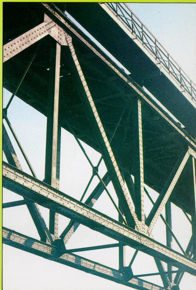
Streben (schräg) und Pfosten (senkrecht)
