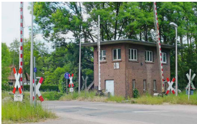
Das Fahrdislenkstellwerk in Wulfen ist bis heute noch in Betrieb und steuert über Doppeldrahtzugleitungen zwei Form-Blocksignale.
