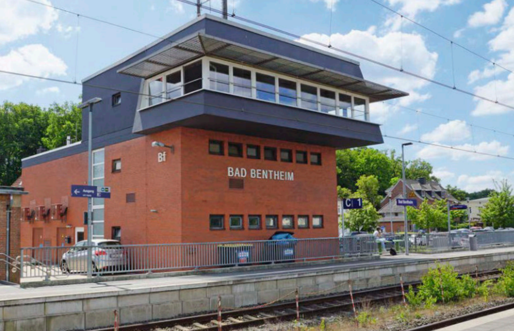
Spurplan-Drucktastenstellpulte des Typs SpDr S60 von Siemens sind auch heute noch im Einsatz, wie z.B. im Systemwechselbahnhof in Bad Bentheim nahe der Grenze zu den Niederlanden.
