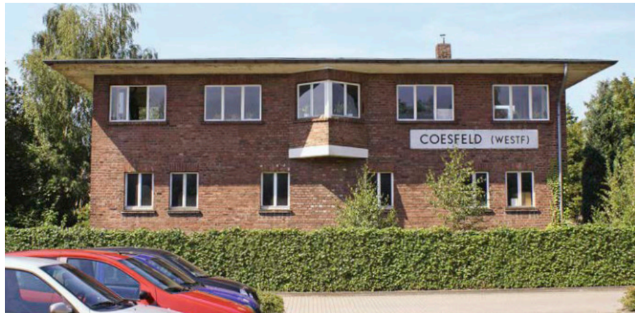
Das Stellwerk Coesfeld (Cn) beherbergte ein mechanisches Stellwerk mit Wechselstromblock und wurde rückgebaut. MEHBÜ bietet ein naturgetreues Modell an (gegenüberliegende Seite oben).
