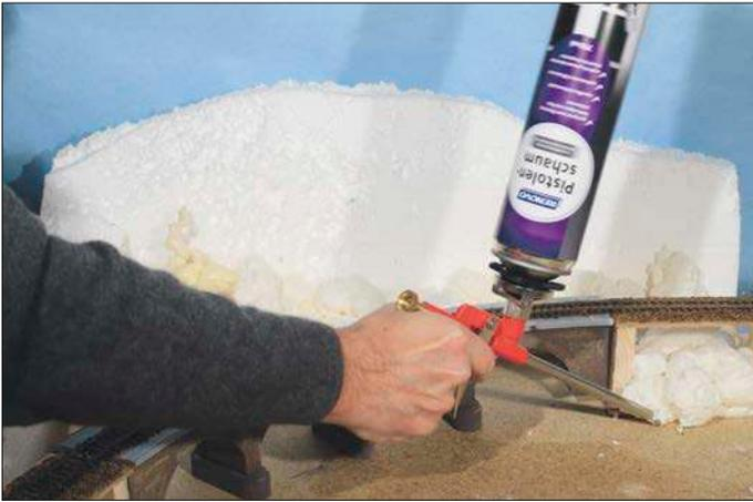
Die Modellierung des Geländes erfolgte wieder mit dem Schaum aus der Pistole, der auch unter das Trassenbrett gespritzt werden kann.
