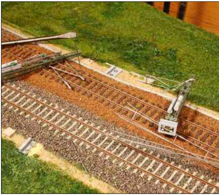
Hier wurde die alte Fahrleitung komplett entfernt. Die teils festgeklebten Fundamente mussten nicht selten herausgestemmt werden.
