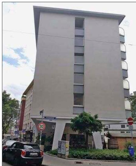
**Rechts: Die zwei thematisierten Baustile nebeneinander. Während das modernisierte Gebäude links wieder die Rasterfront mit vielen Einzelfenstern zeigt, bietet das Bürogebäude rechts im Bild in jedem Stockwerk durchgehende Fensterfronten, die mit Sichtbetonplatten vertikal getrennt wurden.**
