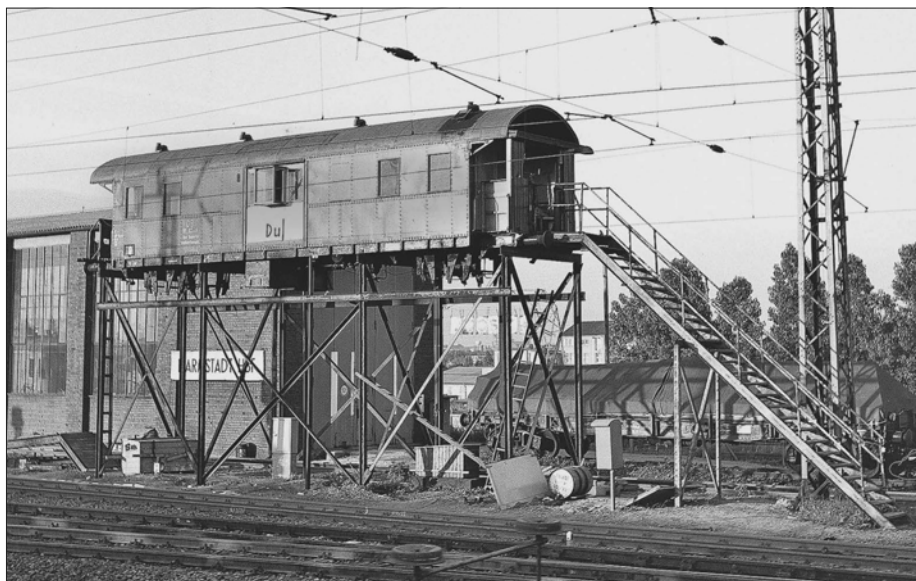
Einen noch filigraneren Unterbau als unser Modell hat das Darmstädter Behelfsstellwerk „Du“ neben der TVT-Halle im nördlichen Gleisvorfeld des Hbf. Es handelt sich um eine Donnerbüchse mit zum Teil verschlossenen Fenstern. Fotos oben und Mitte: Joachim Claus, Eisenbahnstiftung
