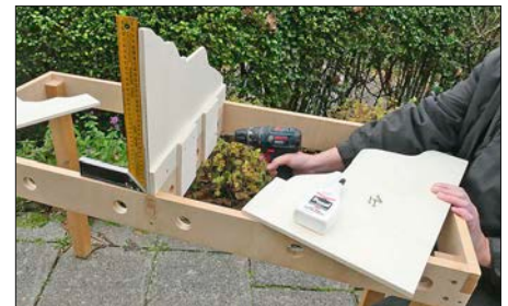
Beim Montieren der Spanten auf den Rahmenhölzern sollten diese immer senkrecht stehen.
