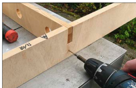
Neben dem Verleimen mit Holzleim werden die Verbindungen zusätzlich auch verschraubt.
