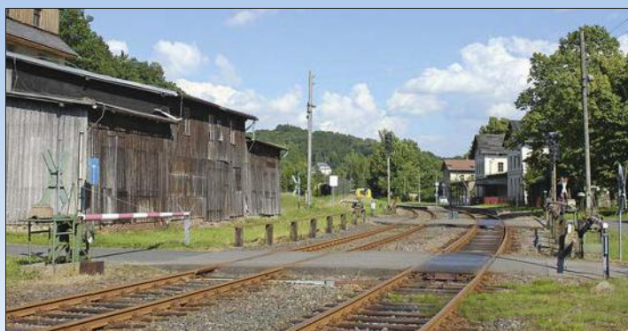
In Mulda (Sachsen) werden vier Schrankenbäume vom Empfangsgebäude aus bedient (Bild oben).
