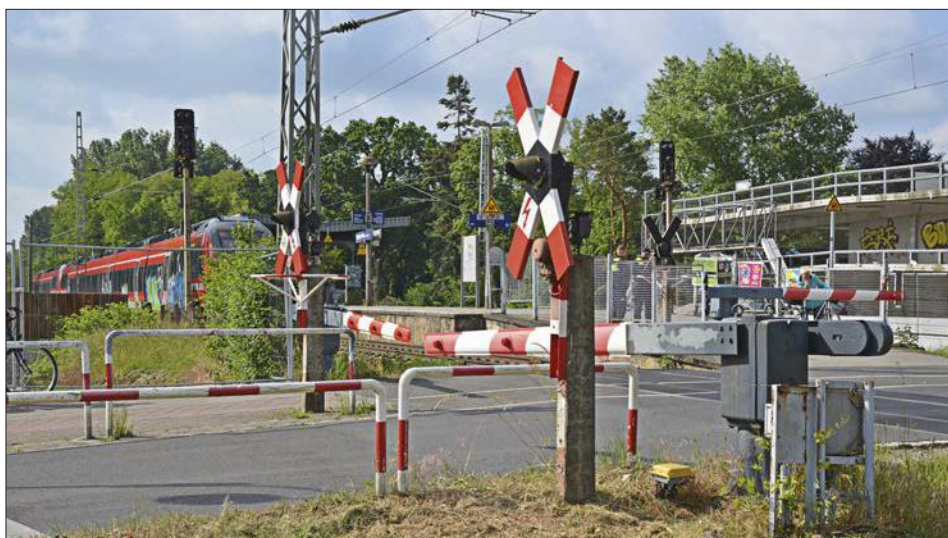
Unten: WSSB-Halbschränkenanlage mit Vollabschluss, wie sie häufig an breiteren Straßen zum Einsatz kam. Das hintere Andreaskreuz besitzt einen runden Schutzbügel. Bild: Bernd Stahr
