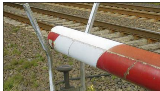
Oben: Detailansicht vom Übergang der komplett reflektierenden Klebefolie zur klassischen Lackierung.
