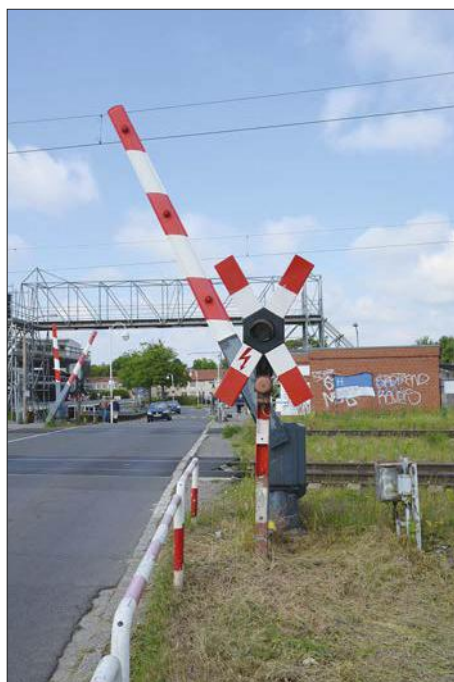
Oben: „Standard“-Halbschränken und Blinklichtkombination der WSSB-Hs64. Die „Knubbel“ in der Schranke blinken hier entgegengesetzt zum Andreaskreuz. Bild: Bernd Stahr
