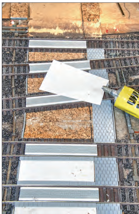
0,75 mm dickes Polystyrol gleicht die noch fehlende Höhe der Schienenklemmen aus.
