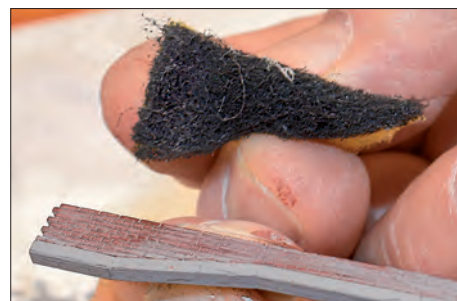
Mit einem Filz legt man die Mauerfugen frei.
