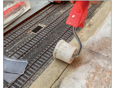
Den Sand drückt man mit einem schmalen Tapetenroller gleichmäßig in den feuchten Leim.
