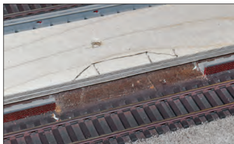
Ein Sperrholzstreifen dient als Kern für den Bahnsteig. Die Aussparungen sind markiert.
