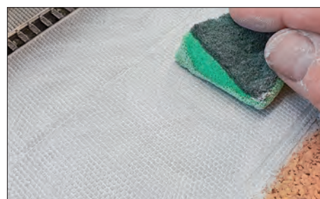
Mit einem feuchten Schwamm werden anschließend die Pflastersteine wieder freigelegt.
