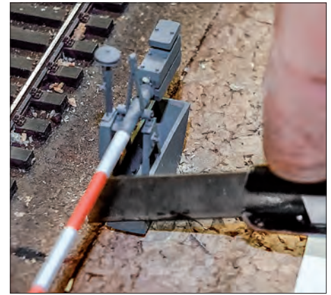
Die Abmessungen des zu versenkenden Kastens kann man mit einem scharfen Messer übertragen.
