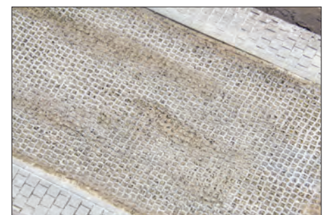
Alternativ hat sich das Verschmieren von Molotofill mit anschließendem Säubern bewährt.
