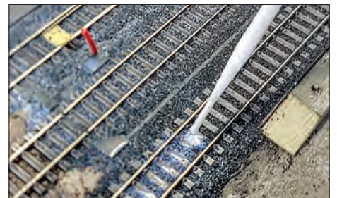
Nachdem die Schienen vom Schotter ordentlich gereinigt sind, beginnt das Verkleben.
