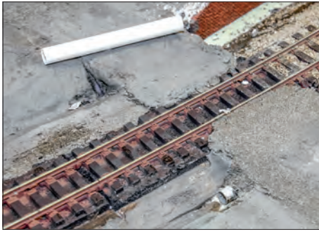
An Übergängen imitiert bei Entwässerungsgräben ein Kunststoffrohr einen Wasserdurchlass.
