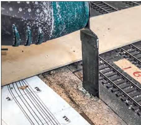
Mit einer Stich- oder besser mit einer Tauchsäge schneidet man das erforderliche Loch aus.
