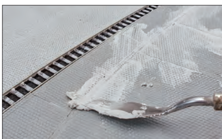
Um die sichtbaren Schnittspalten und Stoßkanten zu kaschieren, wird Moltofill verstrichen.
