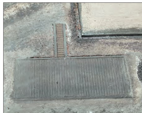
Nahtlos fügt sich der Gestängekanal in die Umgebung ein und muss nur noch gesandet werden.
