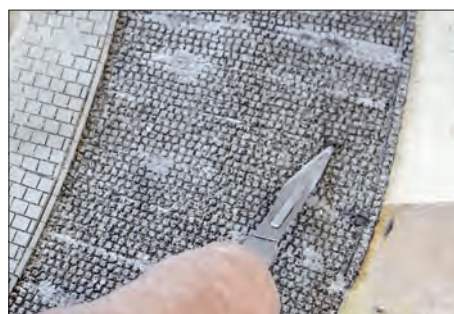
In Kurven wurden die Spalten zwischen den geschnittenen Straßenstreifen zugespachtelt.
