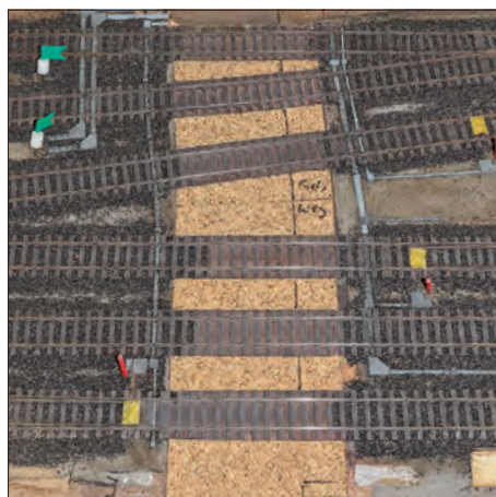
Mit Kork werden die Zwischenräume und Zufahrten auf Schwellenoberkante aufgefüttert.
