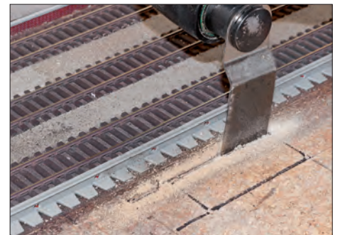
Mit einer Tauchsäge wird das erforderliche Loch für den Treppenabgang ausgeschnitten.
