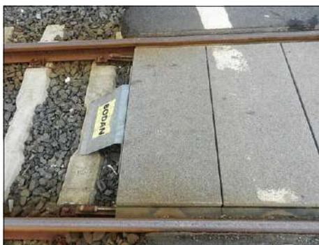
Weit verbreitet sind heute außerdem noch Betonplatten für die Fahrbahn zwischen den Gleisen. Die Metallrampe soll herabhängende Kupplungsteile und Bremschläuche vor Beschädigung bewahren.
