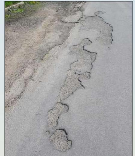
Hier reichen die Beschädigungen vom Rand aus sogar in die Fahrbahn hinein und machen den schichtweisen Aufbau deutlich.
