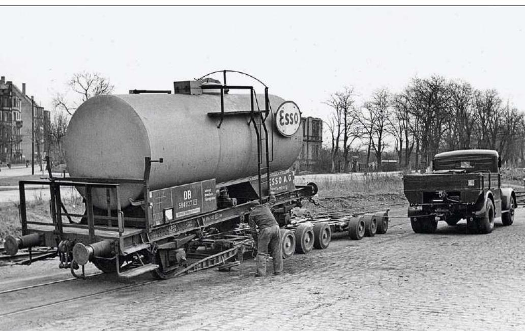
1956 wurde dieser Kesselwagen in Hanau verladen. Gut zu sehen ist, dass die Räder der Auf-fahrrampe abgezogen werden, sobald diese fest am Straßenroller montiert ist. Das Zugseil ist in die dafür vorgesehene Spillöse eingehängt.
