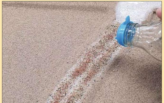
Die Grobmischung wird anschließend mit feinem Wegekies oder Sand angestreut, was das Grobmaterial wieder etwas verschwinden lässt.
