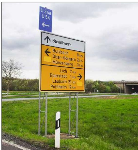
Moderner Tabellenwegweiser in der Ausführung nach 1992. Während die Fahrziele der Umgebung auf gelbem Grund dargestellt werden, hat das örtliche Ziel, das Basaltwerk, eine weiße Kennzeichnung. Detail am Rande: Die kreuzende Straße wurde von einer Bundesstraße zu einer Landstraße abgestuft und die Hinweise auf die B-Nummer überblecht. Fotos: Michael Weiß
