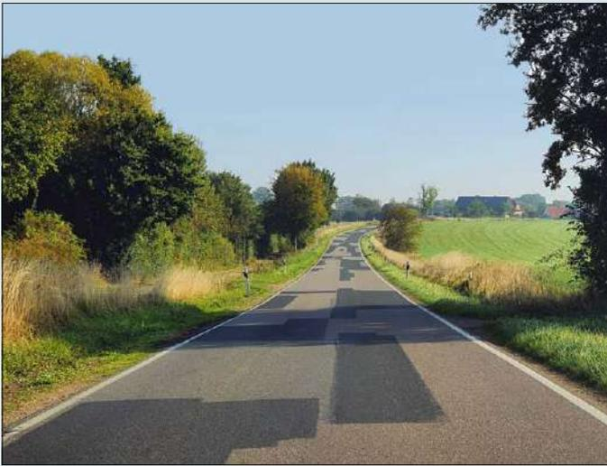
Die einfachste Form einer untergeordneten Straße: etliche Ausbesserungen, nur Randmarkierungen und Leitpfosten mit einer Gesamtbreite der Fahrbahn bis 5,5 m. Diese Art Straßen für eine Verkehrsdichte bis 3000 Kfz/Tag eignen sich wegen ihrer Breite für alle Modellbahnen.
