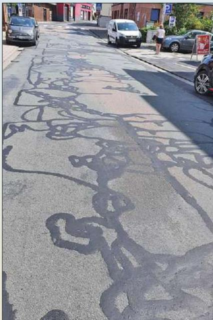
Bei diversen Kanalarbeiten (Wasser, Abwasser, Telefon, Kabel usw.) wurde diese Ortsstraße mehrfach aufgerissen und wieder zuasphaltiert. Unterschiedliche Asphaltmischungen führten zu vielfältigen Farben. Zusätzlich sind Setzrisse und Frostschäden mit flüssigem Bitumen verfüllt worden, um sie zu schließen – hierdurch entstand eine geradezu surreal anmutende Zeichnung aus schwarzen Linien.
