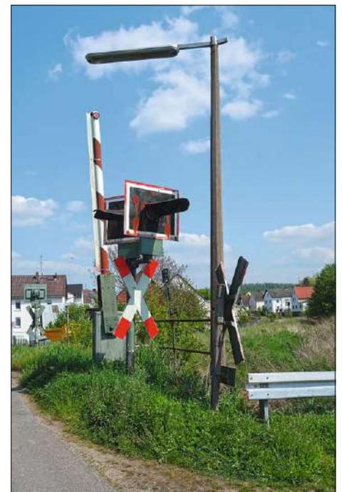
**Links:** Das Ganze noch einmal in Modern und auf der Landstraße. Die Schranken sind komplett rückstrahlend. Weiterhin schützen Leitplanken die Sicherungsanlagen vor Beschädigung. Gut erkennbar ist auch die rechtwinklige Ausrichtung zur Straße.
