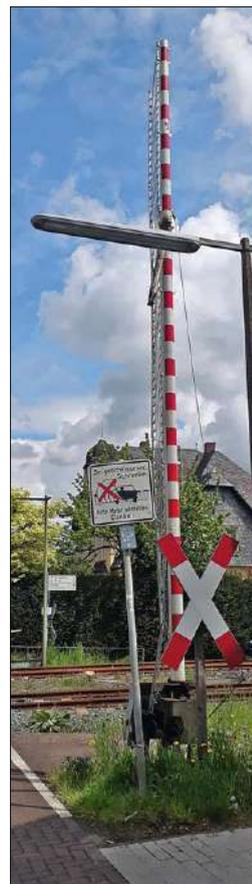
Weiterhin wurden sowohl Straßenschilder als auch Signaltafeln mit retroreflektierenden Elementen für eine bessere Sichtbarkeit bei Nacht ausgerüstet. Dabei entfiel das gelbe Hinweislicht am Überwachungssignal und wurde zum rückstrahlenden gelben Punkt.
