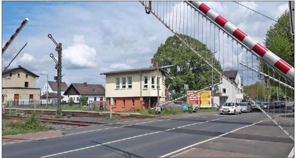
**Oben:** Aus vier Halbschranken besteht dieser innerörtliche Bahnübergang. Da der Schrankenwärter (auch 2019 noch) vor Ort ist, schließen sich alle Schranken gleichzeitig, denn es kann durch ihn visuell überprüft werden, ob der Bahnübergang frei ist.
