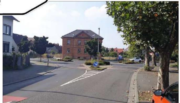
Die von links kommende Hauptrichtung wird im Bereich vor der Kreuzung durch eine Sperrfläche geteilt, die am Ende die Breite des Abbiegerfahrstreifens hat, um diesen abzusichern. Innerorts ist die Sperrfläche der Geschwindigkeit entsprechend häufig mit Schraffur in Schmalstrich ausgefüllt. Auf der anderen Seite wird die Einfädelung in die Abbiegespur oftmals auch mit einer kleinen
