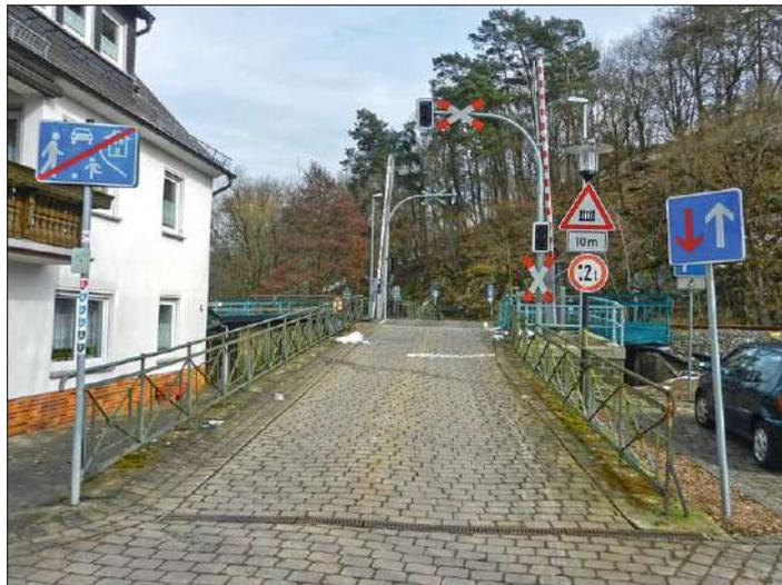
**Oben:** Bei beengten Verhältnissen wird aufgrund der ohnehin niedrigen Straßengeschwindigkeiten auf eine lange Ankündigung verzichtet und nur mittels eines Warnschildes und einer Entfernungsangabe gearbeitet. Hinzu kommt noch ein Auslegermast an der Haltlichtanlage. An solchen findet man auch heute noch waagerechte Andreaskreuze.
