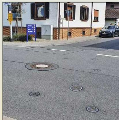
Links: Diverse Schieberabdeckungen an einer Straßeneinmündung mit dahinter stehenden Hinweisen auf Wasser, Gas und Hydrant sowie Mannloch in der Straßenmitte. Oft finden sich die kleinen Schilder auch direkt an Hauswänden, Mauern usw.
