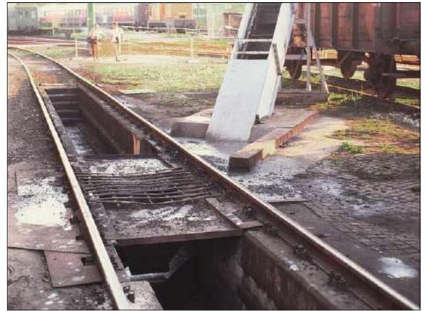
Rechts: 051 864 steht hier auf der Ausschlackanlage im Bw Hohenbudberg. Die kleine Grube zwischen den Gleisen kann mit Gittern verschlossen werden. Es können beidseitig je eine Lok entschlackt werden.
