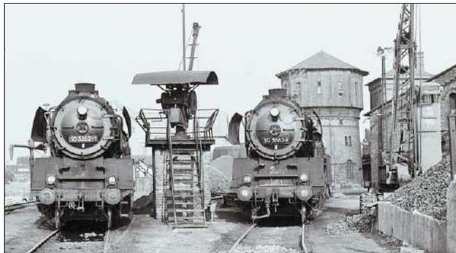
Ein kleines Bahnbetriebswerk, in dem die Loks mit Säulendrehkränen bekohlt und dann in einen kleinen Lokschuppen abgestellt wurden, war Oschersleben in Sachsen-Anhalt. Das Bw befand sich parallel zu den Bahnhofsgleisen der Hauptstrecke und konnte beidseitig angefahren werden. Foto: Jan Methling, Slg. sk
