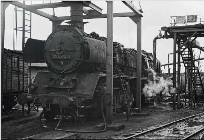
In vielen **Bahnbetriebswerken** nutzte man **lange Zeit Dampfloks** zum **Heizen**. Den **Dampf** führte man mit einem **langen Schlot** über der Lok nach oben. Neben der 50 3693 befindet sich ein **Gerüst** zum **Betanken** von Ölloks der DR. Die **Zuleitung zur Zapfstelle** verläuft **oberirdisch**.
