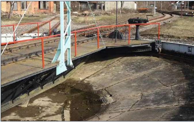
Das Bw Luckau besitzt eine kleine Drehscheibe mit äußerem Zahnkranz für den Antrieb. Der Rand der Drehscheibengrube besteht aus Blech und der Boden aus Beton. Deutlich sind im Beton Fugen und Risse zu erkennen. Unten in der Mitte der Drehscheibengrube sammeln sich Wasser.
