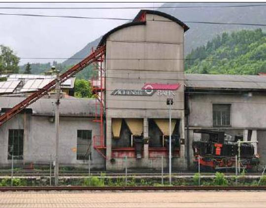
Einen Hochbehälter, der mittels Förderband beschickt wird, findet man in Jenbach (Tirol). Die Loks werden hier über Schütten bekohlt.
