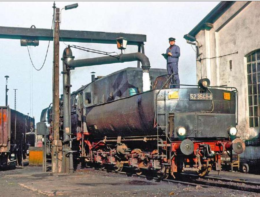
Diese Szene zeigt gut die Anordnung von Bw-Einrichtungen. An der Ausschlackgrube konnten zeitgleich zum Ausschlacken die Wasservorräte ergänzt werden. Der Portalkran mit Laufkatze hatte die Aufgabe, die Hunte mit der Schlacke und Lösche aus der Grube zu heben. Auf dem vom Kran überspannten Nachbargleis steht ein offener Güterwagen, in dem die Schlackenunte entleert werden konnten. Foto: Slg. sk
