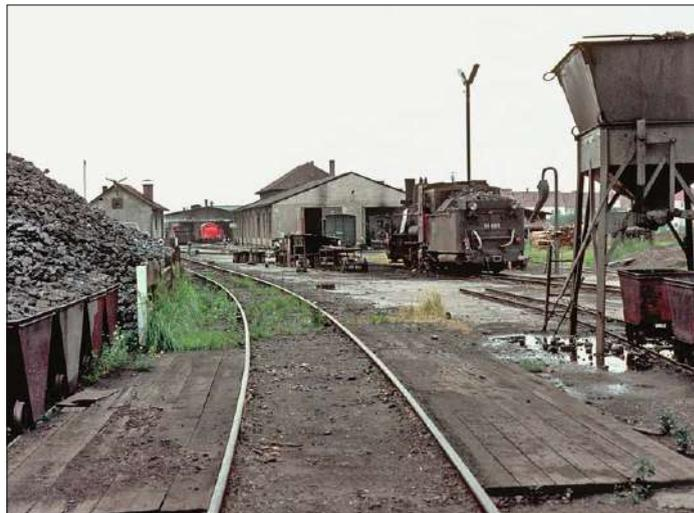
In Putbus auf der Insel Rügen werden die Loks ebenfalls mit Hunten bekohlt. Ein kleiner Kran hebt sie über den Kohlenkasten. Ein Gestell hinter der Lok erleichtert den Eisenbahnern das Entladen der Hunte. Die Bekohlung liegt an einem Nebengleis direkt vor dem Lokschuppen der Bäderbahn. Fotos (2): sk
