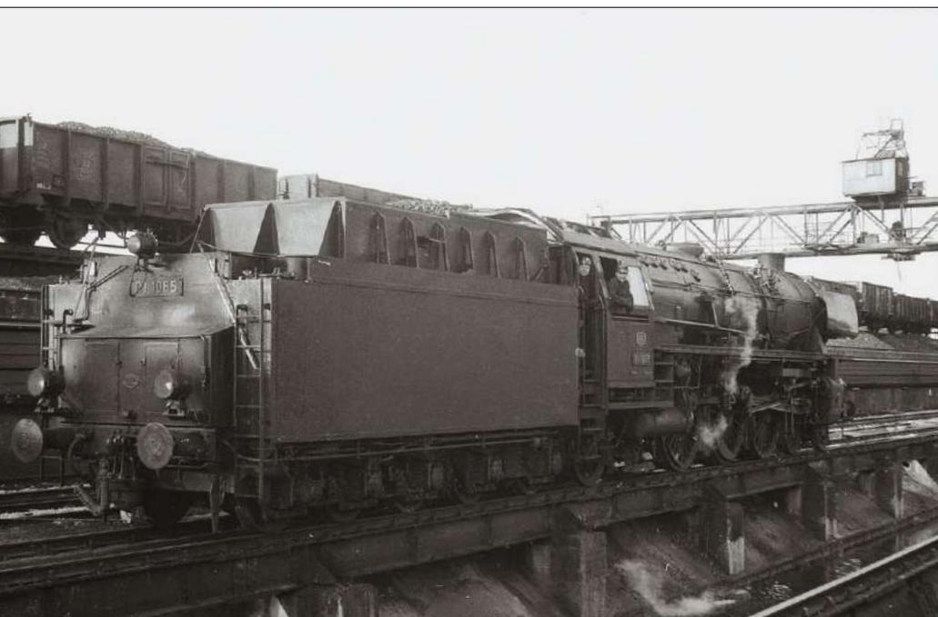
Links: Im Bw Osna-brück befand sich ein großer Schlackensumpf, auf dem mehrere Loks gleichzeitig entschlackt werden konnten. Die Schlacke lief über Schrägen unter dem Gleis in den mit Wasser gefüllten Sumpf und wurde von dort dann in ruhigen Betriebszeiten ausgebaggert. Für die Ver- und Entsorgung der Bw-Anlagen stand ein fahrbarer Portalkran zur Verfügung, der auch die Bekohlung übernahm. Foto: Slg. sk
