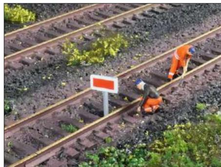
**Die Warntafel kann nicht nur als Stumpfgleisabschluss, sondern beispielsweise auch zur Abariegelung unbefahrbarer Gleise oder als temporäre Begrenzung von Gleisen im Falle einer Baustelle aufgestellt werden.**
