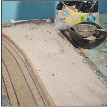
Die Anlegefläche wird mit gesiebtem Vogelsand belegt. Er wird anschließend mit einem Raket (z.B. einem Lineal) glatt abgezogen.
