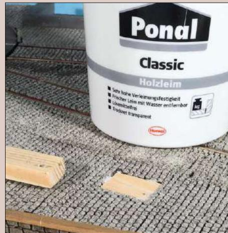
Aufnahmeblöcke zum Verschrauben der Mastfüße werden gesetzt.
