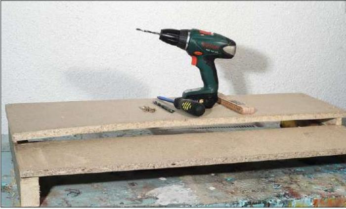
Die zwei Grundplatten für das Hafengebäude und den Ladeplatz werden mit breiten Holzleisten auf einer Distanz von 40 mm verschraubt.
