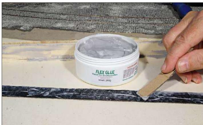
Verklebt wird mit Flex Glue. Dieser Klebstoff – ein Kontaktkleber, der Korrekturen auch nach der Auflage noch zulässt – ist hier ideal.
