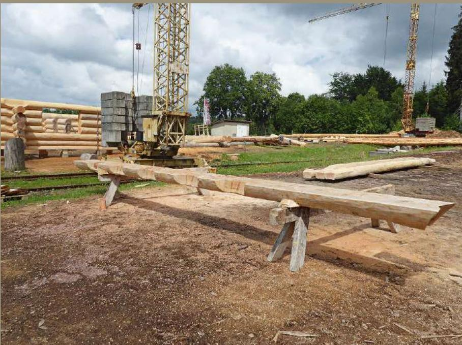
Oben links: Einer der langen, bereits sorgfältig entrindeten Baumstämme liegt zur weiteren Bearbeitung bereit.
