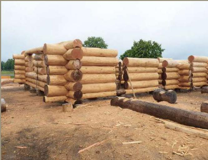
Im Prinzip bestehen Blockhäuser aus rechtwinklig aufeinander liegenden, entrindeten Stämmen. Die Rundhölzer sind – wie man oben sieht – auf der Unterseite ausgekehlt, sodass die Rundung auf dem darunter liegenden Stamm rutschfest aufsitzt.
