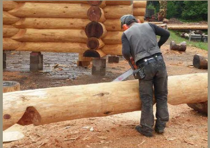
Oben: Die aufgebockten Stämme werden entsprechend den vorher angezeichneten Markierungen mit der Kettensäge genauestens zugeschnitten. Wichtig ist dabei, dass das zu bearbeitende Werkstück ruhig und fest liegt.
