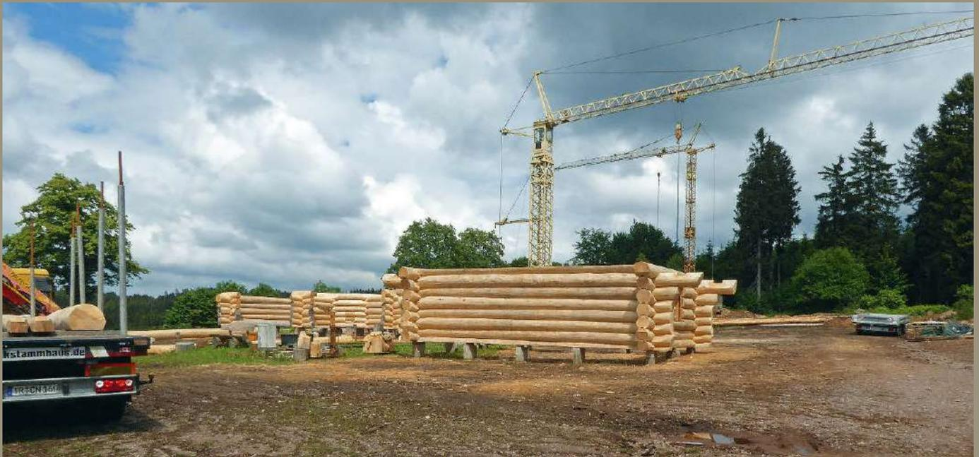
Gleich mehrere Blockhäuser sind auf dem Gelände der Blockstammhaus GmbH in Zerf zu finden. Nach dem Zurichten der Stammabschnitte werden die Blockhäuser probenhalber errichtet, um zu sehen, ob alles passt. Danach erfolgt der Abtransport zum Kunden.
