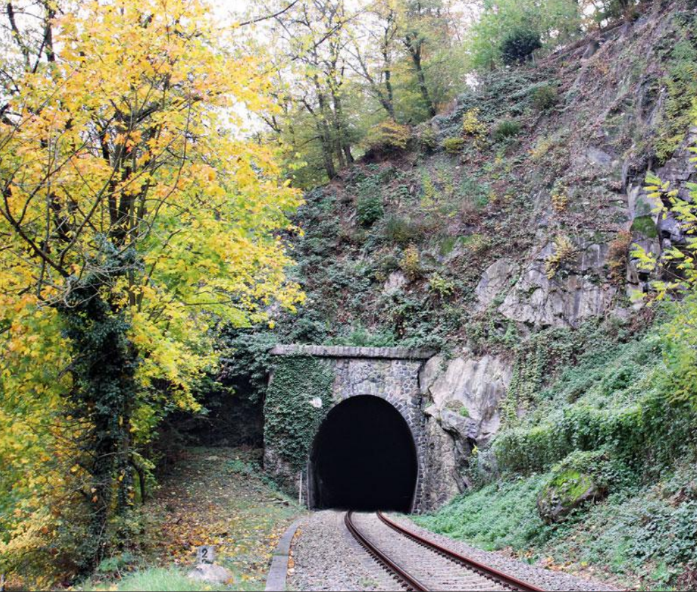
Das Ostportal (aus Bruchsteinen) ist mittlerweile schon reichlich mit Efeu überwuchert. Auch die umgebende Vegetation ist trotz des felsigen Untergrundes deutlich dichter, als man es auf historischen Aufnahmen sehen kann.
