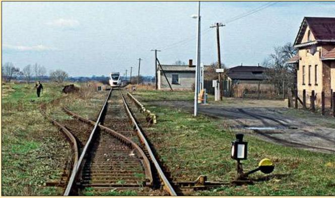
Ferchland zwischen Güsen und Jerichow besaß einen kurzen Bahnsteig am Hauptgleis. Hinter dem Triebwagen ist eine Weiche zu erkennen, die in eine kurze Umfahrung und eine Ladestraße für den Güterverkehr führte. Über dieses Ladegleis kreuzten in Ferchland auch Personenzüge.
