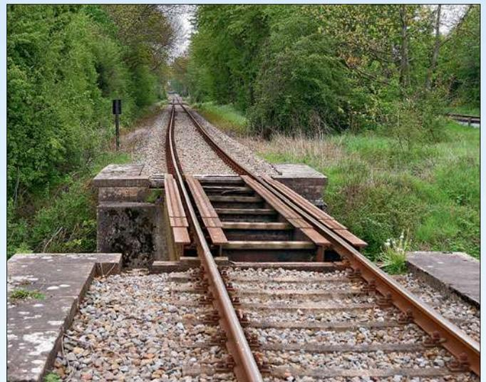
... Doppel-T-Profilen, die mit Querstreben vernietet sind. Zwischen den Trägern sind Aufnahmen für die Schienenprofile verbaut. Auf den Stahlträgern sind zusätzliche Bleche vernietet, die ein Durchbiegen der Träger erschweren. Die Widerlager sind so breit ausgeführt, dass das gesamte Schotterbett aufgenommen werden kann.
