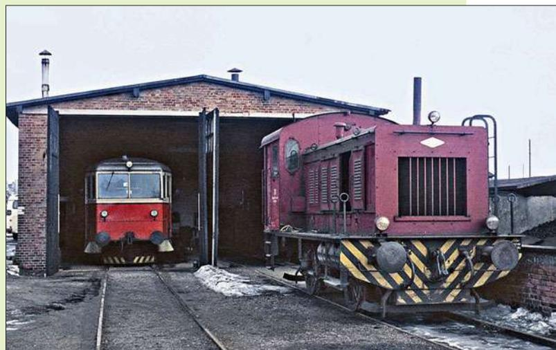
In Lüchow befand sich die Werkstatt mit einem zweistöckigen Lokschuppen. Neben dem DWK-Triebwagen 156 steht die V20 der LSE. Deutlich sind an der Lok der ursprüngliche Kühlergrill zu erkennen. Die Lok kam 1961 über die Bremervörde-Osterholzer Eisenbahn (BOE) von der Heeresmunitionsanstalt Zeven zur LSE. Bei der BOE erhielt sie die Nummer 261.
