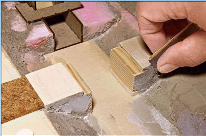
Die Widerlager entstanden bereits beim Rohbau des Segmentes. Im Bereich des Grabens wurde die Anlagengrundplatte ausgespart und ein tiefer liegendes Bett mit Böschung errichtet. Die Widerlager entstanden aus Sperrholz und wurden in die Böschung eingearbeitet. Spachtelmasse verdeckt Fugen und imitiert Beton.
