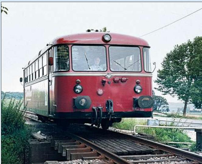
Bei dieser kleinen Brücke wurden die Holzschwellen direkt auf zwei Stahlträger unter den Schienen verbaut. Die Widerlager bestehen aus Beton. Zum Schutz von Streckenläufern oder anderen Bahnmitarbeitern wurde der Gleiszwischenraum im Bereich der Brücke mit Holzbohlen abgedeckt. Foto: Struck, Slg. S. Koch
