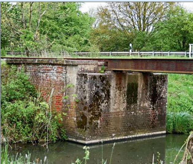
Diese kleine Brücke befindet sich zwischen Eystrup und Hoya. Sie verfügte einst über gemauerte Widerlager aus Ziegeln, die bei späteren Reparaturen mit Beton instand gesetzt wurden. Deutlich ist auf dem linken Bild die Verwitterung durch Regenwasser und Moos zu erkennen. Der Brückenträger besteht aus ...
