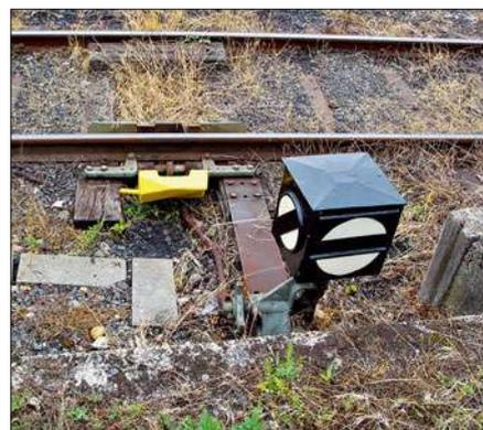
Üblicherweise haben diese Gleissperren noch eine Signallaterne, die dem Lokführer die Stellung der Sperre anzeigt.
