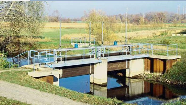
Dieses moderne Stauwehr aus Stahlbeton in der Magdeburger Börde regelt den Wasserhaushalt von großen Ackerflächen. Es besitzt zwei Verschlüsse aus Metall, die nach unten gekurbelt werden können.
