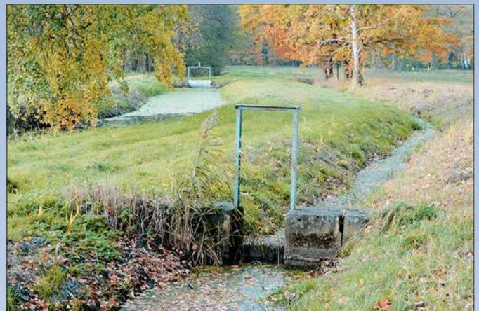
Bei diesem Wehr erkennt man den Wasserunterschied zwischen Ober- und Unterwasser. Im Hintergrund ist ein modernisiertes Stauwehr mit Stahlverschluss für den größeren Wasserlauf links sichtbar.
