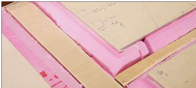
Beim Rohbau der Segmentkästen wurden die Verläufe der Entwässerungsgräben aus der Anlagen Grundplatte ausgespart und ein niedrigeres Grundbrett errichtet.
