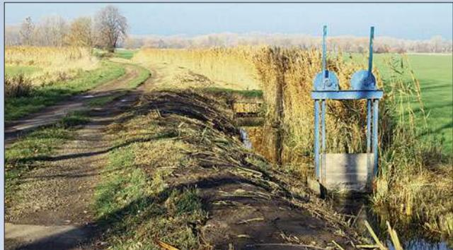
Der Staugraben mit dem Wehr ist hier zu erkennen. Der Verschluss kann mit zwei Kurbeln und Lochstangen bewegt werden.
