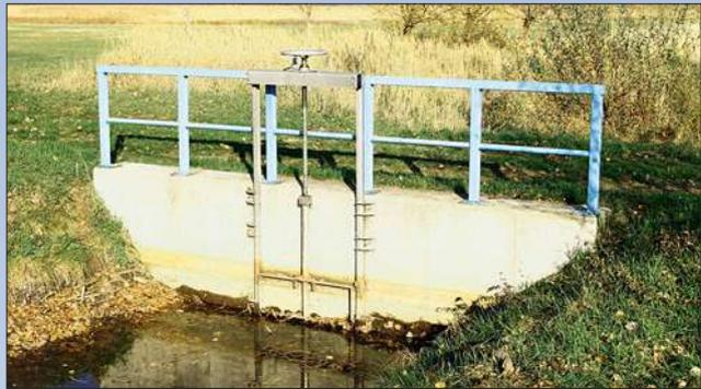
Dieses kleine Stauwehr besitzt eine Gewindestange mit Handrad, wodurch der Verschluss des Wehres betätigt werden kann.
