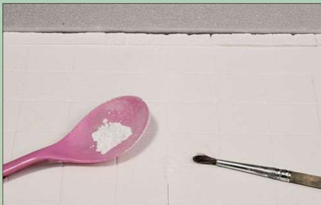
Bei etwas größeren Lücken wird zunächst trockenes Gipspulver (Spezialgips von Langmesser) in die Nahtstellen gefüllt ...
