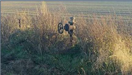
Regner zur Bewässerung von Ackerflächen wurden samt den zugehörigen Rohrsystemen in den Boden integriert. So wie hier eine Konstruktion aus DDR-Zeiten mit Kreisregnern, die auf Wasserleitungen montiert sind, welche aus dem Boden ragen. Zum Anschluss von beweglichen Regnern gab es am Feldrand Flansche, die an Wasserleitungen hingen. Absperrhähne waren zum Steuern des Wasserflusses vorhanden.
