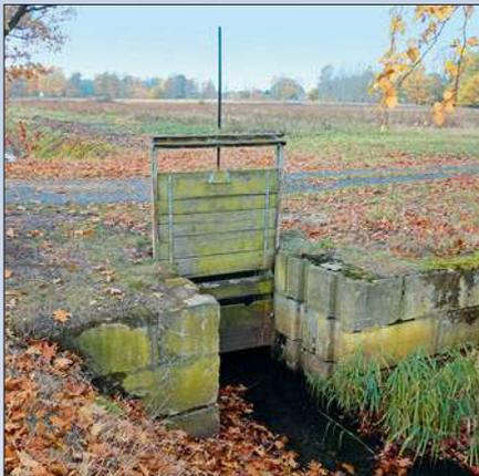
Dieses Stauwehr hat einen Verschluss aus Holzleisten, die in einer Führung nach unten gelassen werden können. Vor dem Wehr wurde eine Stützwand aus großen Steinen gemauert. Hinter dem Verschluss befindet sich ein Durchfluss, der von einem Weg überquert wird.
