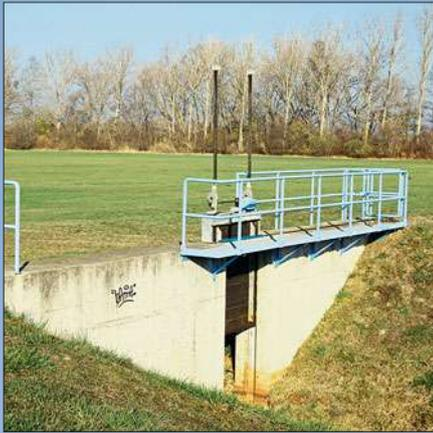
An kleineren Wasserläufen in den Ackerflächen findet man einfache Wehre mit einem Verschluss, der in einer Führung in der Betonwand nach unten gekurbelt werden kann. Über dem Wehr ist ein Wehrsteg vorhanden.
