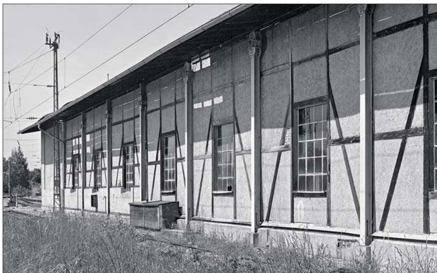
Der Fahrzeugschuppen in Murnau wurde in Fachwerkbauweise erstellt und erhielt später vorgesetzte Doppel-T-Träger. Die Aufnahme entstand am 25.5.1986. Foto: Stephan Beständig
