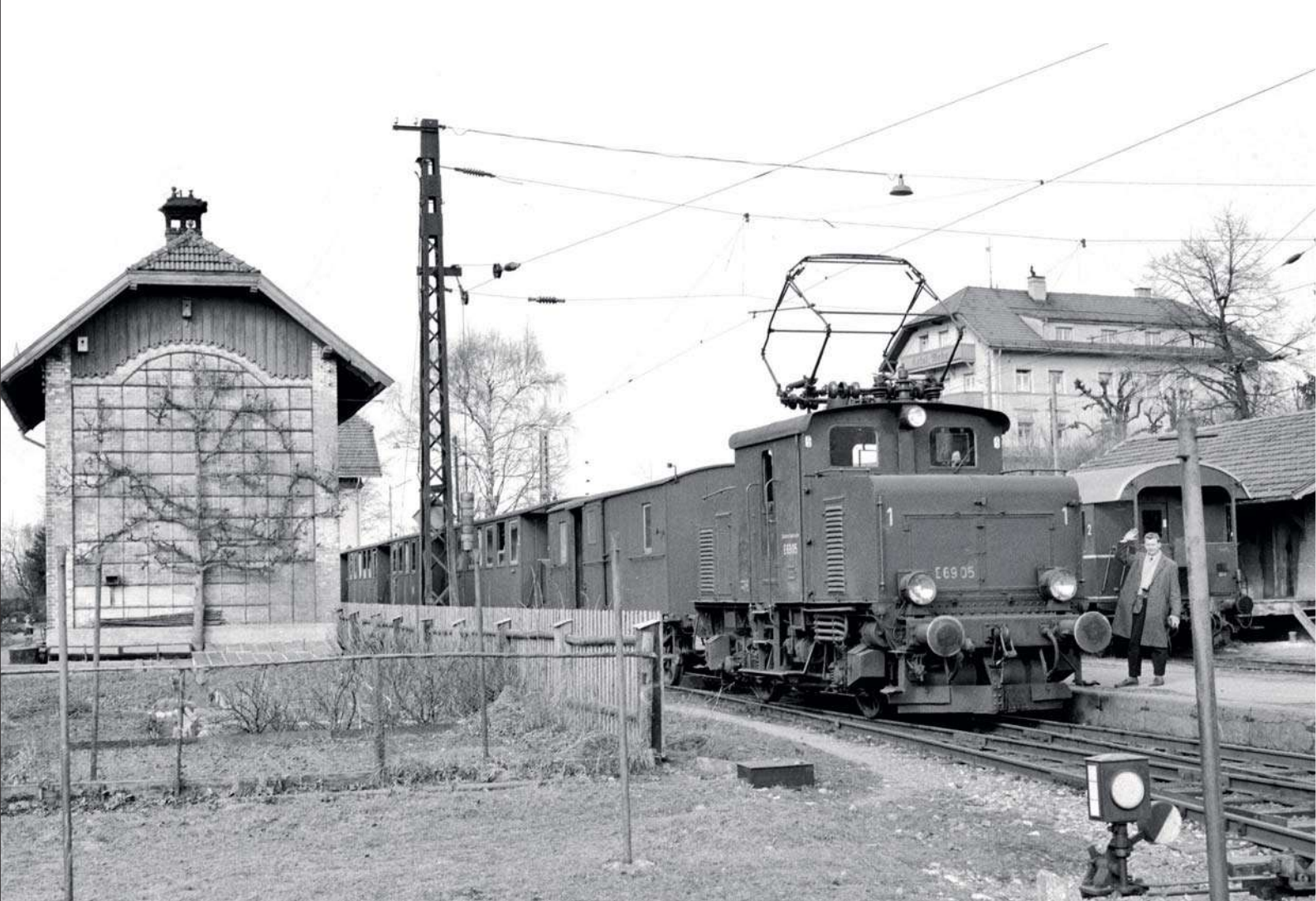
Wenige Meter östlich des Staatsbahnhofs errichtete die Lokalbahn 1898 einen eigenen Bahnhof. Die Station verfügte über zwei Bahnsteiggleise, die an einem Mittelbahnsteig lagen. Außerdem befand sich westlich des Bahnsteigs noch ein Gütergleis. Im Lokalbahnhof steht am 6.3.1959 die E 69 05 mit einem Zug nach Oberammergau. Foto: Gerd Wolff, Slg. Eisenbahnstiftung
