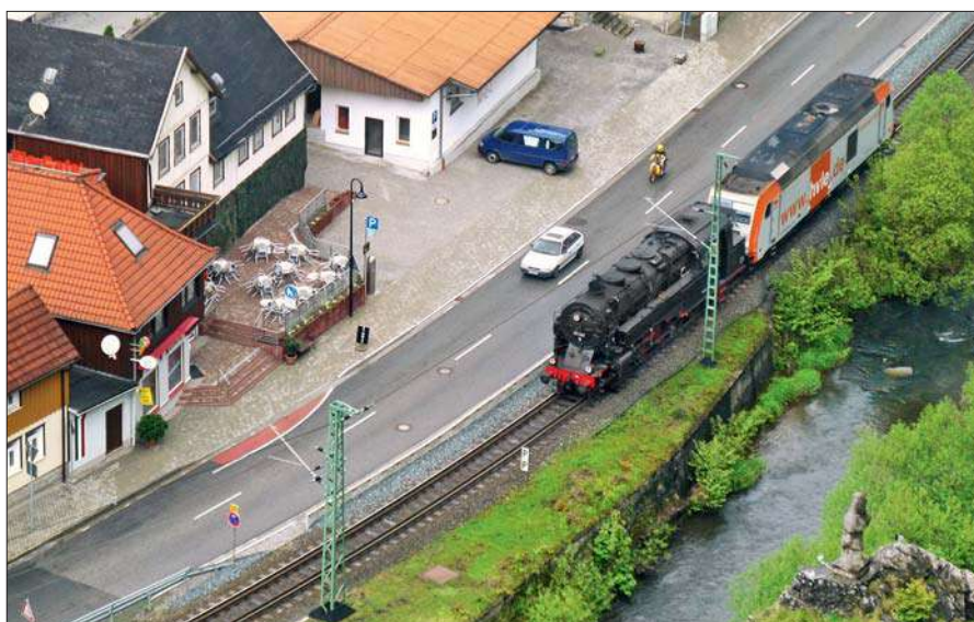
Der Blick von oben zeigt die Enge der Ortsdurchfahrt – Straße und Bahn teilen sich das schmale Tal mit dem kleinen Fluss Bode. Der Bär auf dem Felsvorsprung entstand mit der Einrichtung der Tropfsteinhöhlen als Ausflugsziel. Die 95 1027 wurde von Dirk Brandenburg während der Indienststellung 2010 abgelichtet.
