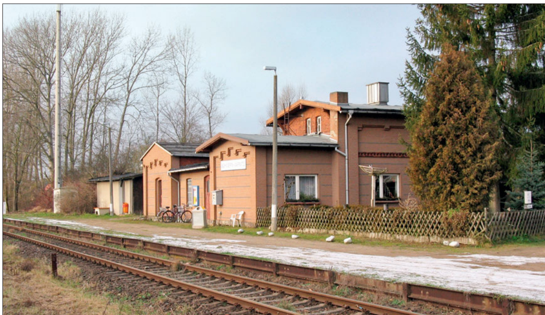
Der Haltepunkt Schwerin-Warnitz liegt an der Bahnstrecke Schwerin-Rehna in Mecklenburg-Vorpommern. Er hat ebenfalls wieder viele Merkmale, die man nachbilden kann. In meinem Fall gab er die Anregung der Bahnsteigkanten aus Stahlschwellen. (Bild in https://commons.wikimedia.org/wiki/File:Schwerin_Warnitz_Haltepunkt.jpg , Bildautor: Niteshift)
