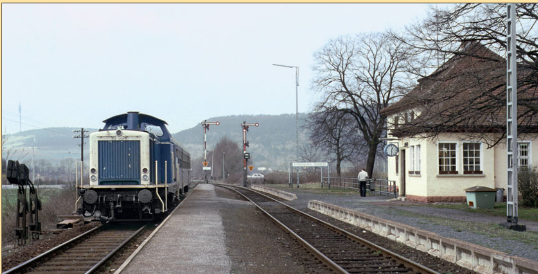
In Elfershausen fotografierte Jens Franzke am 4. April 1995 den N8111 mit 212 350. Deutlich ist der Inselbahnsteig mit der einseitigen Bahnsteigkante und dem Zugang über das Gleis zu erkennen. Vielerorts wird zum Schutz der Reisenden an der nicht genutzten Kante ein zusätzlicher Zaun aufgestellt. Foto: Jens Franzke, Sammlung Koch
