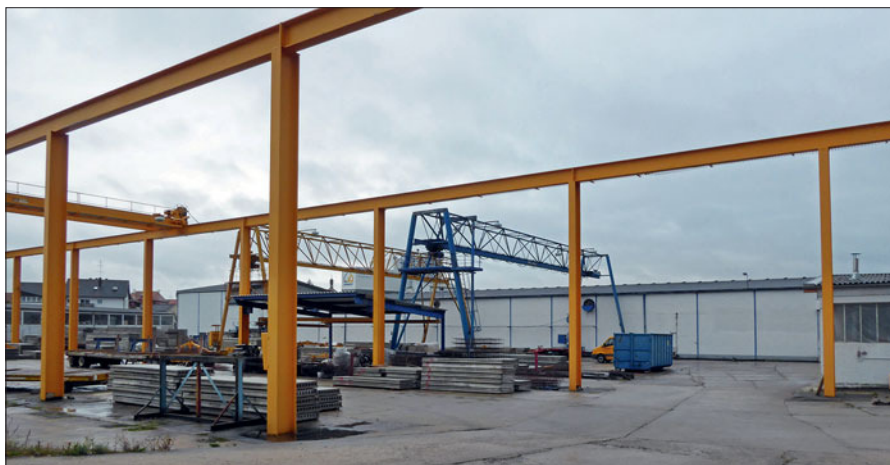
Im Betonfertigteilelager übernehmen Laufkräne das Versetzen der Elemente.
