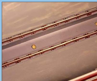
Um diese Untersuchungsgrube zu beleuchten, wurden kleine LEDs in diese befestigt.
