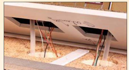
Neben den Kabeln bzw. Drähten für die Beleuchtung werden auch die Schläuche unter die Anlagengrundplatte geführt.
