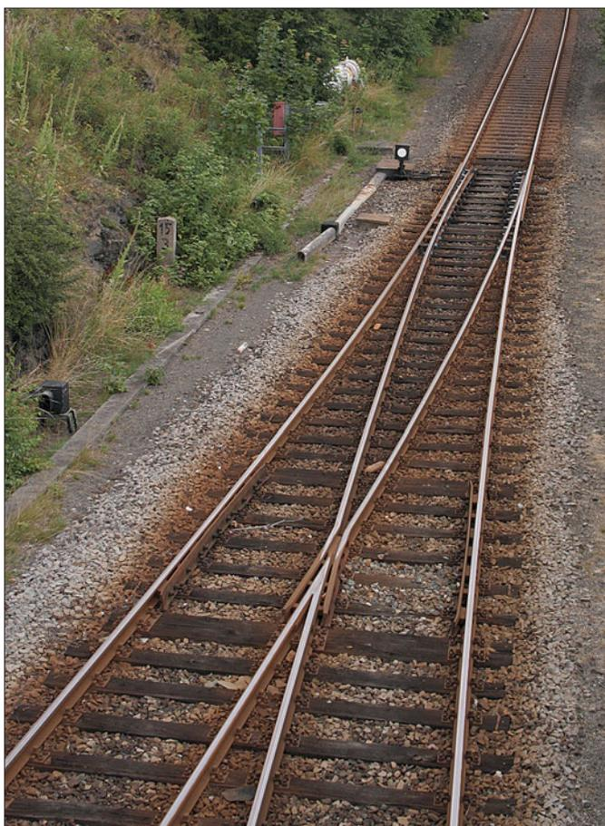
In der Draufsicht auf diese Außenbogenweiche sind alle Bauteile zu erkennen. Im Vordergrund der Herzstückbereich mit den Radlenkern, im Hintergrund die Zungen mit der Stellvorrichtung und dem Weichenantrieb. Die Weiche besitzt noch Doppelschwellen, obwohl die Schienen anscheinend alle geschweißt sind.
