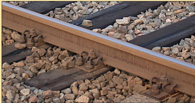
Links eine Variante der Bauart KS. Sie entspricht zwar der Bauart K, doch wurden Klemmplatte und Federring durch eine Spannklemme ersetzt.
