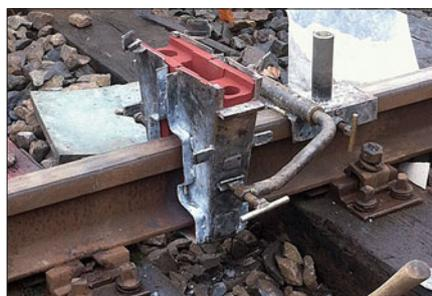
Beim Thermitschweißen wird eine Gießform um die zu verbindende Stelle zwischen zwei Schienenprofilen gelegt, in die flüssiges Eisen gelangt. Da die hochfeste Form dicht ist, kann das flüssige, glühende Material eine dauerhafte Verbindung mit dem Stahl der beiden Schienen eingehen. Im Foto rechts aluminothermisches Schweißen in einem Weichenwerk. *Fotos: Sebastian Koch*
