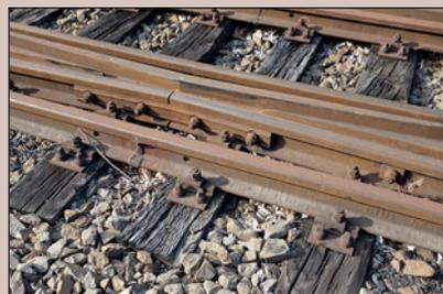
Herzstücke und Flügelschiene sind bei Kreuzungsweichen aufwendige Bauteile; weshalb man heute nach Möglichkeit Kreuzungsweichen durch einfache Weichen ersetzt. Die Herzstückbereiche sind mit Schienenlaschen und Schrauben montiert. Die Weiche ist hier mit der Schienenbefestigung K auf Holzschwellen montiert.
