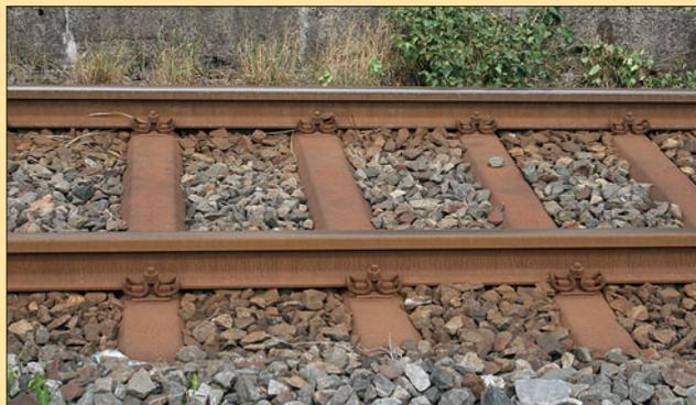
Stahlschwellen verkörpern Hohlformen, die zu einer stabilen Lage im Schotterbett beitragen. Zur Aufnahme der Schienenbefestigung bediente man sich der Schweißtechnik.
