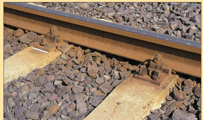
Je nach Streckenbelastung gab es auf Betonschwellen Rippenplatten, die mit zwei (links) oder vier Schwellenschrauben (rechts) über Schwellendübel mit den Schwellen verschraubt wurden.
