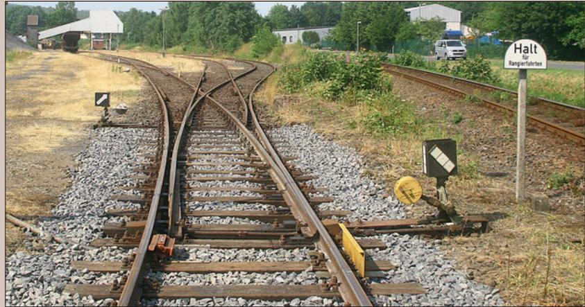
Doppelweichen besitzen neben dem Stammgleis zwei Zweiggleise. Oben ist eine zweiseitige Doppelweiche zu sehen. Doppelweichen bestehen aus zwei ineinandergeschobenen einfachen Weichen. Hierdurch spart man deutlich an Baulänge, hat aber ein Herzstück mehr. Die Weiche liegt in einem Gleisanschluss und wird mit Handstellgewichten gestellt.
