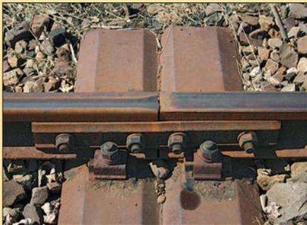
Oben: Ruhender Stoß auf einer älteren Doppelschwelle aus Stahl.
