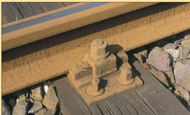
Befestigungsvariante der Bauart K. Die Rippenplatte wurde hier mit vier Schwellenschrauben auf den Schwellen befestigt. Die Hakenschraube hält die Klemmplatte über dem Schienenfuß.
