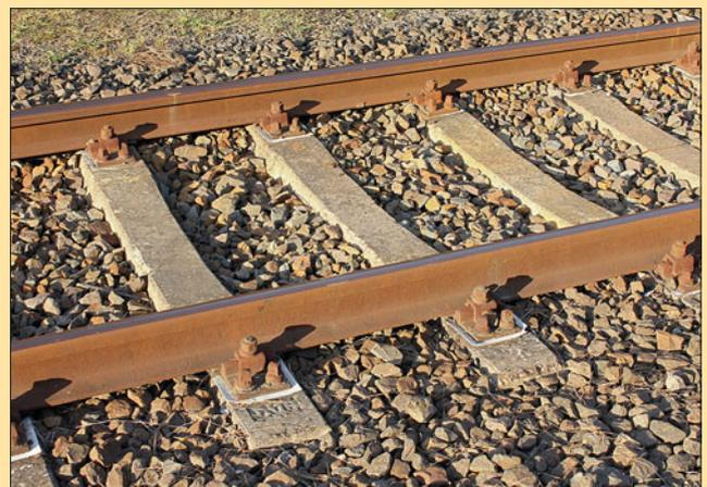
Oben: Beide oberen Fotos zeigen B55-Schwellen. In den Beton sind Dübel eingelassen, die dem Verschrauben der Schienenbefestigungen dienen. Ganz oben ist ein „leichter“ Oberbau mit einfacher Schwellenverschraubung zu sehen, darunter ein massiver Oberbau mit doppelter Verschraubung auf den Schwellen.
