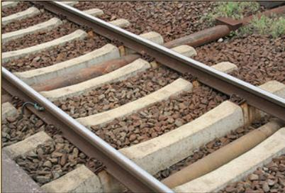
Oben: Die B70-Schwelle mit ihren kleinflächigen Aussparungen für die Winkel­führungsplatten der Schienenbefestigung gilt als Standardschwelle der Epoche IV.
