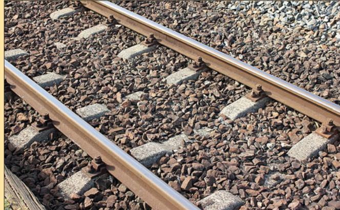
Ältere Beton­schwellen, wie man sie auf Neben­strecken findet, zeigen von heutigen Bau­formen ab­weichende Querschnitte; hier Betonschwellen auf der „Heidekrautbahn“ nördlich Berlins.
