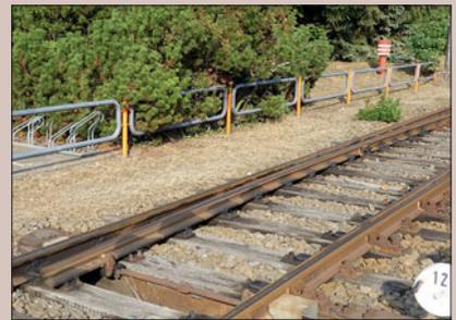
Das Herzstück der Weiche besteht aus einem gehobelten Bauteil und wurde mit den Flügelschienen verschraubt. Da in der Herzstücklücke der Spurkranz des Rades führungslos ist, muss das andere Rad des Radsatzes beidseitig geführt werden. Dazu dienen die Radlenker an der Backenschiene. Die untere Bildreihe zeigt links den Zwischenschienenbereich mit Backen- und Flügelschie-
