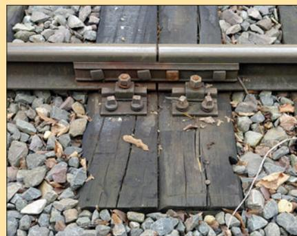
Auf den beiden Bildern links sind ruhende Stöße auf Doppelschwellen erkennbar. Bei den Laschenverbindungen befindet sich der vierkantige Kopf der Schrauben außen und die Muttern an den Innenseiten.
