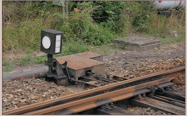
Bei der DB hielt man dagegen an der alten Bauform fest; die Abdeckungen der Kästen bestehen aus Riffblech, welches mangels Wasserablauf meist mehr oder weniger stark rostig ist.
