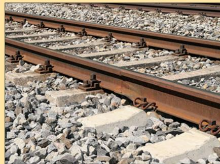
Dieses Foto dokumentiert den Übergang von der Schwellen B55 mit S54-Schienen auf B70-Schwellen mit UIC60-Schienen.
