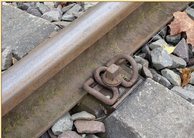
Die Bauart W in der Draufsicht. Deutlich sieht man die Winkelführungsplatte und eine Schienenunterlage aus Gummi, die unter dem Schienenfuß für die dauerelastische Schienenauflage sorgt.
