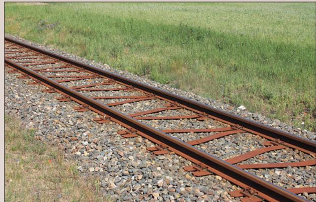
Die gebogen geformten Stahlschwellenprofile verleihen dem Gleissystem sein spezifisches Aussehen. Sie ermöglichen ein schmaleres und niedrigeres Schotterbett.
