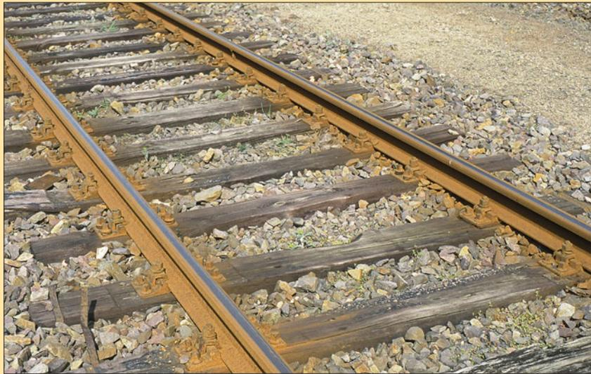
Holzschwellen bestehen in der Regel aus speziell imprägniertem Hartholz. Neuwertige Schwellen zeigen infolge der Imprägnierung eine dunkelbraune Färbung, während ältere Schwellen hellbraun bis grau erscheinen. Hier dienen Schwellenschrauben und Kleisen zur Schienenbefestigung. Ältere Oberbauformen kamen auch mit einfachen Schwellennägeln und Klammerungen (mithin ohne Kleisen) aus. Die Nutzungsdauer von Holzschwellen liegt deutlich unter der von Stahl- und Betonschwellen.
