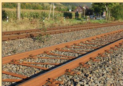
Das Foto zeigt die eher seltenen Y-Stahlschwellen aus speziell verformten Stahlprofilen, die zu Schwellenpaaren verschweißt sind. Die Konstruktion garantiert zwar hohe Stabilität gegenüber Querverschiebungen und gestattet ein niedrigeres, kostengünstiges Schotterbett, konnte sich aber nur wenig durchsetzen.
