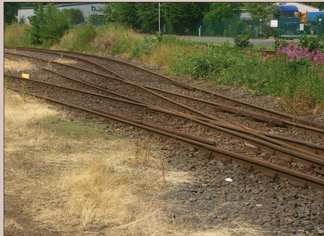
Der Bereich von Herzstück und Radlenkern bei einer Doppelweiche im Detail. Die Radlenker fallen gegenüber einer normalen Weiche deutlich länger aus, da sie die Führung der Räder über zwei Herzstücke übernehmen. Fotos: Heiko Meyer
