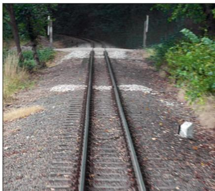
Zwei Vorbildsituationen aus dem fahrenden Zug beobachtet: Offensichtlich wurden hier im Bereich der Schienenstöße neue Befestigungen und neue Schwellen eingebaut.
