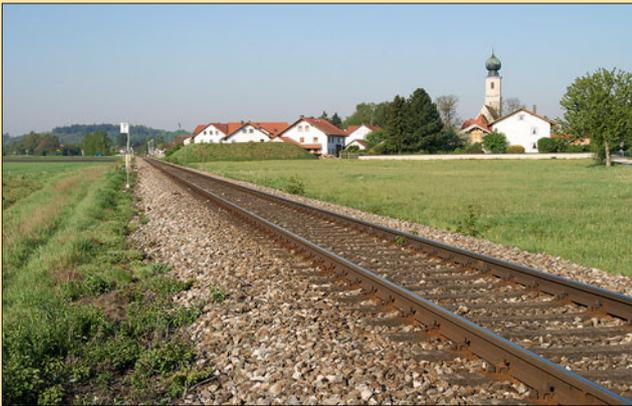
Klassische Oberbauform mit Betonschwellen in einem genormten Schotterbett aus Kalksteinschotter am Beispiel einer bayerischen Nebenbahn. Von entscheidender Bedeutung für eine normgerechte, stabile Gleislage sind effektive Entwässerungsmaßnahmen.
