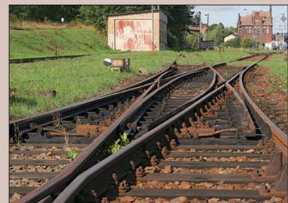
Auf den beiden Bildern oben sind doppelte Kreuzungsweichen mit innenliegenden Zungen (also vor dem Herzstück) abgebildet. Bei einer DKW muss jeder Weichenantrieb vier Zungen stellen. Die Ansteuerung der DKW-Laterne erfolgt über ein weiteres Gestänge seitlich der Weiche. Auf dem rechten Bild sind außerdem noch die Handstellhebel der Weiche zu erkennen.
