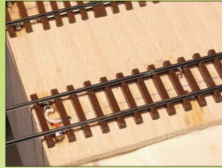
Die Anschlussdrähte werden dann in kleine Bohrungen in den Schwellenfächern durch die Anlagengrundplatte geführt und sind nach dem Einschottern nicht mehr zu sehen.
