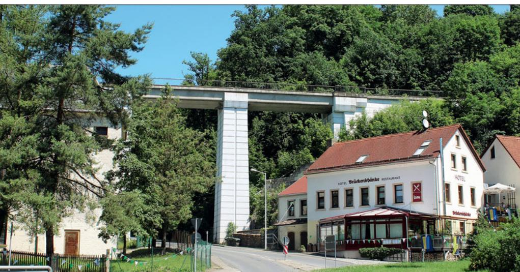
Die detaillierte Ansicht eines der acht Pfeiler des in den 1980er-Jahren neu errichteten Brückenbauwerks. Über dem Giebel des Hauses befindet sich ein Widerlager. Werkfoto: Tillig
