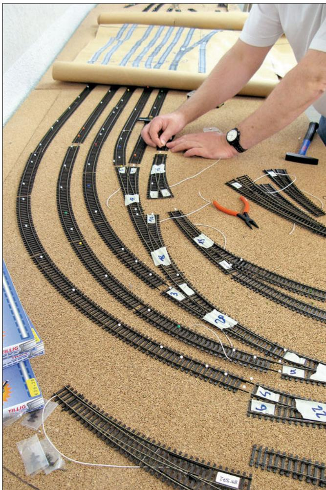
Entsprechend dem 1:1-Plan mit den aufgeklebten Kopierschablonen werden die Gleise und Weichen ausgelegt und probeweise mit Nadeln festgeheftet. Die Tillig-Weichen können bei der Verlegung noch etwas gekrümmt werden, was an manchen Stellen zu einem gefälligeren Gleisverlauf führt. Allerdings muss in erster Linie auf die Betriebssicherheit geachtet werden – also beim Biegen nicht überreiben!
