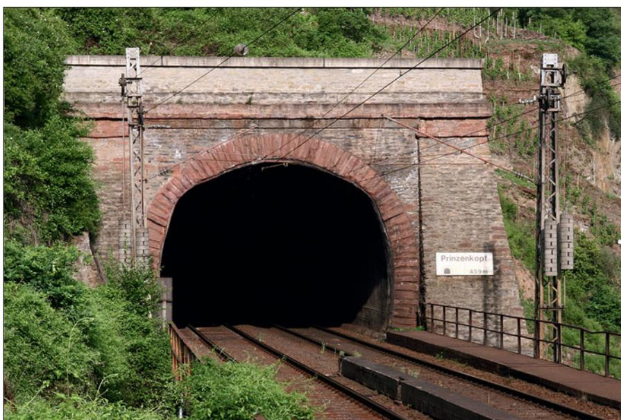
Wenn der Tunnelquerschnitt nicht für die volle Höhe des Kettenwerkes reicht, wird wie hier am Prinzenkopftunnel auch ein weniger hohes Kettenwerk installiert.
