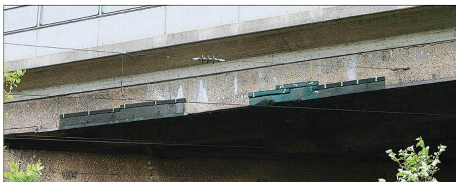
Beide Bauarten an einer Brücke: An der Strecke Bamberg–Forchheim hat die Fahrleitung links ein nachgespanntes Tragseil; hier muss die Kette mit geringer Bauhöhe unter der Brücke durchgeführt werden. Rechts ist ein festes Tragseil direkt am Brückenkörper fixiert.
