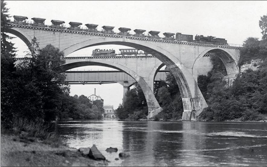
Klassiker als Auftakt: Die beiden Oberen Illerbrücken (auch Südbrücken) von Kempten, hier auf einem bekannten Foto von Carl Bellingrodt, wurden zwischen 1904 und 1906 als (bis heute) größte Stampfbetonbrücken der Welt erbaut. Eine konstruktive und materialtechnische Alternative verkörpert das Epfenhofener Stahlviadukt (unten) im Verlaufe der Sauschwänzlebahn zwischen Oberlauchringen und Immendingen. Foto: Dipl.-Ing. Herbert Stemmler
