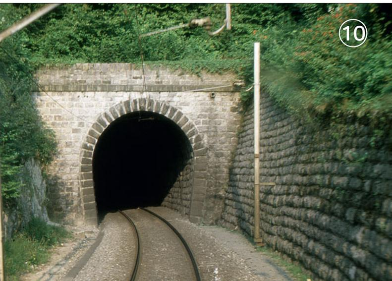
Tunnelportal mit abgesetzter Stützmauer. Foto: *Karl Frischauf 1984*
