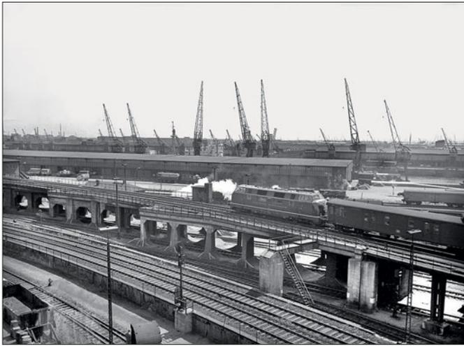
Die fabrikneue V 200 044 mit einem Schnellzug am 22.05.1959 auf der Hamburger Pfeilerbahn zwischen Hauptbahnhof und Abzweig Elbebrücke. In diesem Abschnitt trägt die Pfeilerbahn ihren Namen zu Recht. Zwischen den vielen Stützpfeilern des Betonbauwerks führen mehrere Gleise zum Hafenbahnhof. Foto: *Walter Hollnagel*
