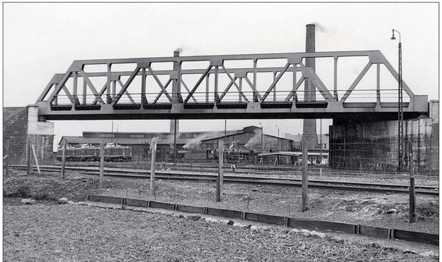
Brückenbau und Brückenunterhaltung von Stahlfachwerktypen boten viele Vorteile, die alle darauf zurückgingen, dass man die Belastung der einzelnen Konstruktionselemente berechnen konnte und so wusste, in welcher Menge und Stärke man sie benötigte. Die Berechnung von projektierten Stahlfachwerkbrücken wurde zu einer oft gestellten Aufgabe für Abschlussarbeiten in der Ingenieurausbildung.
