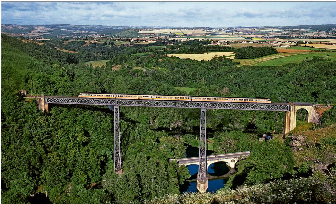
Vielfalt der Stahlbrücken: Zum 1871 in Betrieb genommenen Viaduc de Rouzat über die Sioule bei Saint-Bonnet-de Rochefort (oben), einem frühen Meisterwerk von Gustave Eiffel (!), gehören neben zwei riesigen Gittermastfeilern und drei Stahlgitterträgern die steinernen Widerlager und eine nahezu klassische Steinbogenbrücke.
