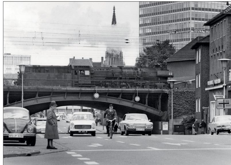
Wie niedrig zum Teil die Gleise über dem Straßenniveau geführt werden, zeigen die beiden rechts abgebildeten Motive mit der BR 012 im Juli 1969. Es handelt sich um die Wolbecker Brücke in Münster. Auf der Südseite zeigt sie sich als Stahlkonstruktion und auf der Nordseite mit Mauerwerk. In einem flachen Bogen spannt sich die Brücke über die Straßen, wobei an den Fahrbahnrändern eine Höhe von lediglich 3,30 m erreicht wird. Fotos: *Ludwig Rotthowe*
