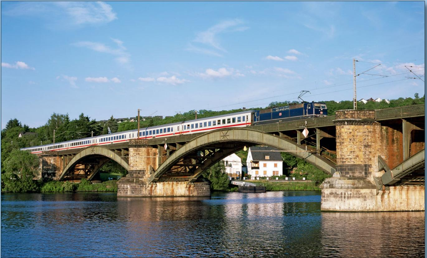
Die Moselbrücke in Koblenz-Güls (oben) kombiniert auf einer Länge von 226 m sandsteinverkleidete Widerlagerbauten mit schmiedeeisernen Bögen. Dagegen entstand die 138 m lange ICE-Brücke über das Eisenbachtal im Verlauf der Schnellfahrstrecke Köln-Rhein/Main als Balkenbrücke komplett in Spannbetonbauweise. Fotos: Udo Kandler
