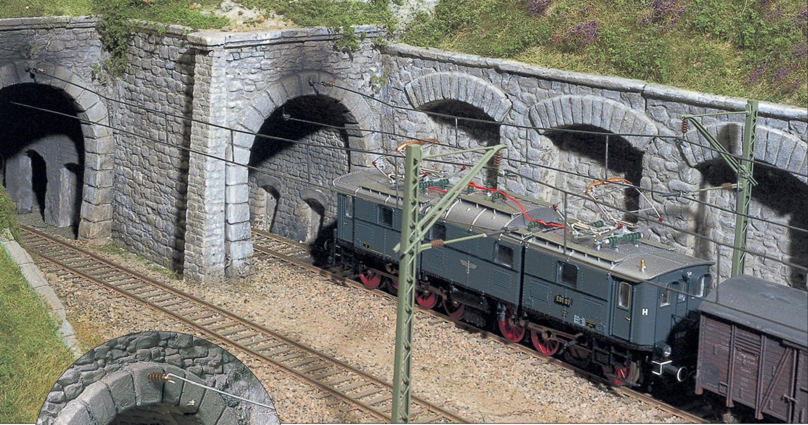
**Oben:** Die niedrige Tunneldecke erfordert die Verankerung des nicht nachgespannten Tragseils am Tunnelportal. Diese stellt den Festpunkt des Tragseils dar, Isolator nicht vergessen! (siehe Detailaufnahme links)
