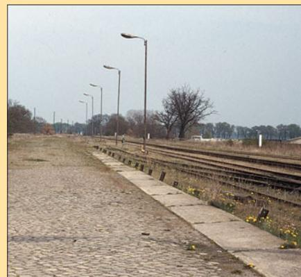
Unmittelbar vor der stabilen Ladestraßenkante aus Betonwerksteinen dienen leicht schräggestellte, ältere Schienenprofile als wirkungsvolle Radabweiser.
