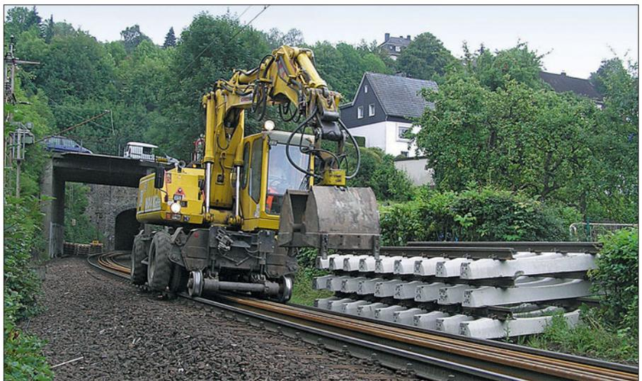
Der Atlas 1604 K ZW-WB bei Gleiserneuerungsarbeiten auf der eingleisigen Strecke zwischen Siegen Ost und Siegen. Im Bild unten ist dagegen der O & K MH-S ZW neben dem Gleis im Bahnhof Siegen Ost zu sehen; die unterschiedliche Bereifung ist deutlich zu erkennen.
