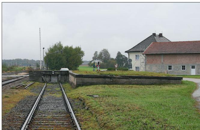
Für den Bau dieser kurzen Rampe im einstigen DR-Bahnhof Wildberg wurde fast nur Beton verwendet. Die oberen Kanten hat man zu ihrem Schutz mit Winkelprofilen aus Stahlblech versehen. Vor allem als Kopf-rampe für die Fahrzeugverladung gedacht, weist bei dieser Rampe vieles auf eine frühere militärische Nutzung hin.
