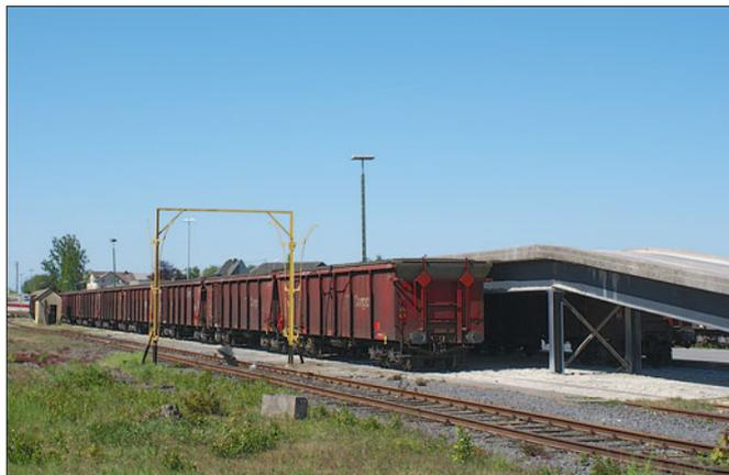
In Siershahn befindet sich eine moderne Hochrampe, von der aus Straßenfahrzeuge Schüttgut in bereitstehende offene Wagen abkippen können. Die etwa 100 m lange Rampe besteht aus einem Stahlunterbau und ist mit Betonplatten abgedeckt.
