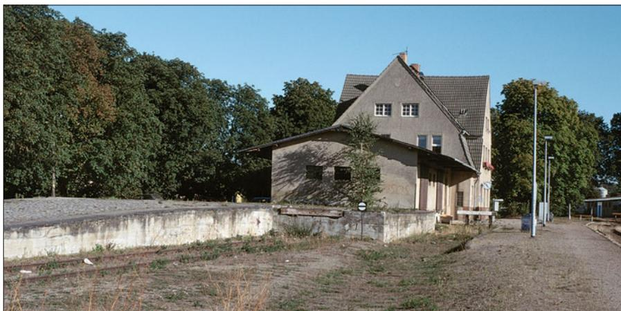
In Feldberg in Mecklenburg-Vorpommern existiert eine Rampe unter Verwendung von Kopfsteinpflaster. Ihre Einfassung besteht aus Beton. Als Kopf- und Seitenrampe (Kombirampe) ist sie mit dem Güterschuppen baulich unmittelbar verbunden und ermöglicht somit auch dessen Bedienung.
