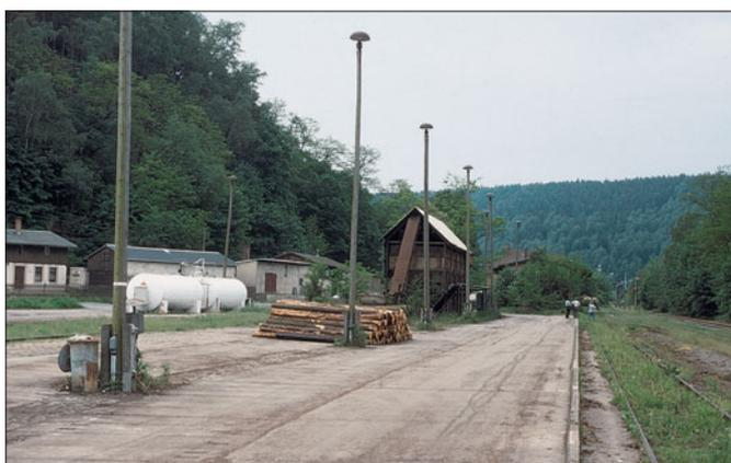
Für die Zwischenlagerung errichteter Kohlehochbunker in Rathmannsdorf. Das Ladegut gelangte über ein Förderband vom O-Wagen in den Bunker und konnte von dort per Schwerkraft in Fuhrwerke und Lkws verladen werden. Die Ladestraße hat eine betonierte Oberfläche.
