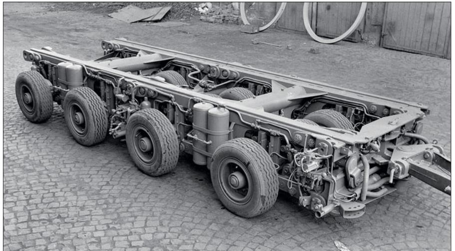
**Ein vierachsiges Schwerlastroller-Fahrwerk LS 70. Bei Bedarf kann aus zwei dieser Fahrwerke eine achtachsige Einheit zusammengestellt werden, die im Bild unten zu sehen ist.**
