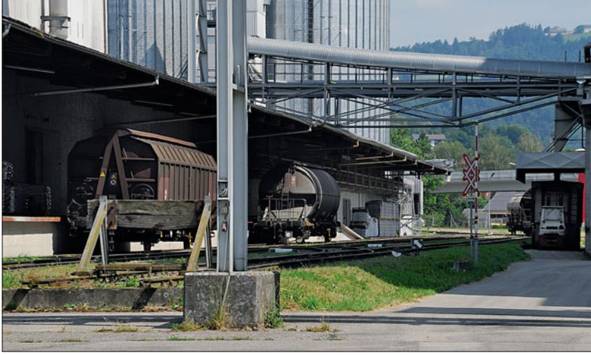
Die Beladung von Tank-Lkws für den Pelletstransport erfolgt im rechten Bildteil. Somit sind die nässeempfindlichen Pellets bei Beladung unter dem Dach geschützt.
